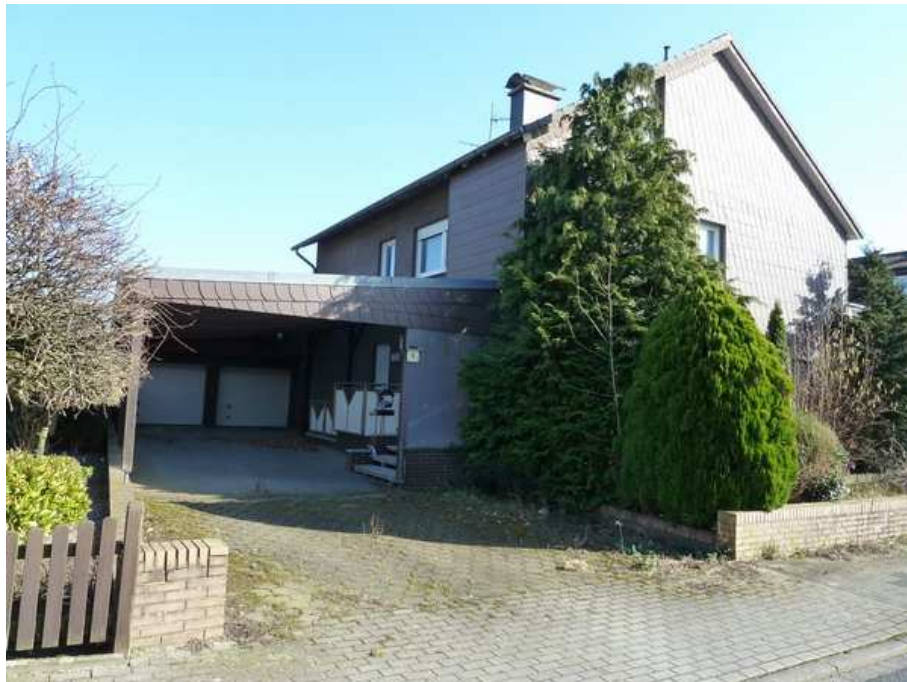
Grundstücksansicht aus Nordwesten
