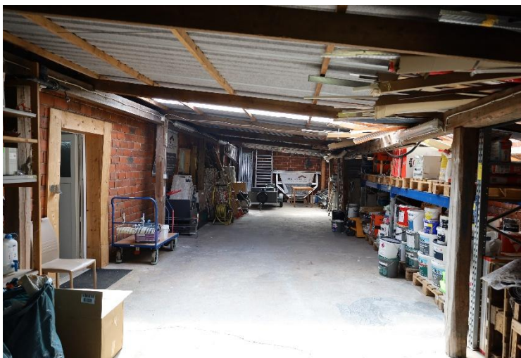
Südliche Lagerfläche im Gewerbeobjekt
