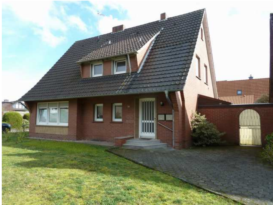
Grundstücksansicht aus Nordosten
