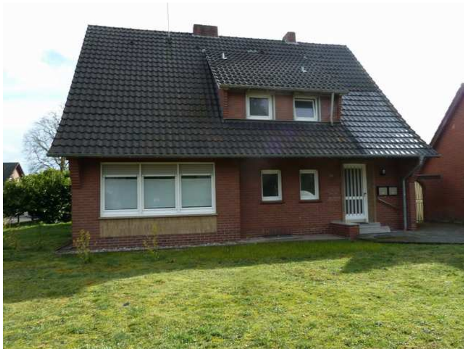
Grundstücksansicht aus Norden
