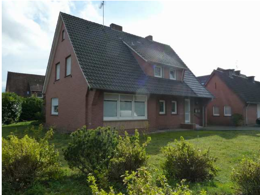
Grundstücksansicht aus Nordwesten
