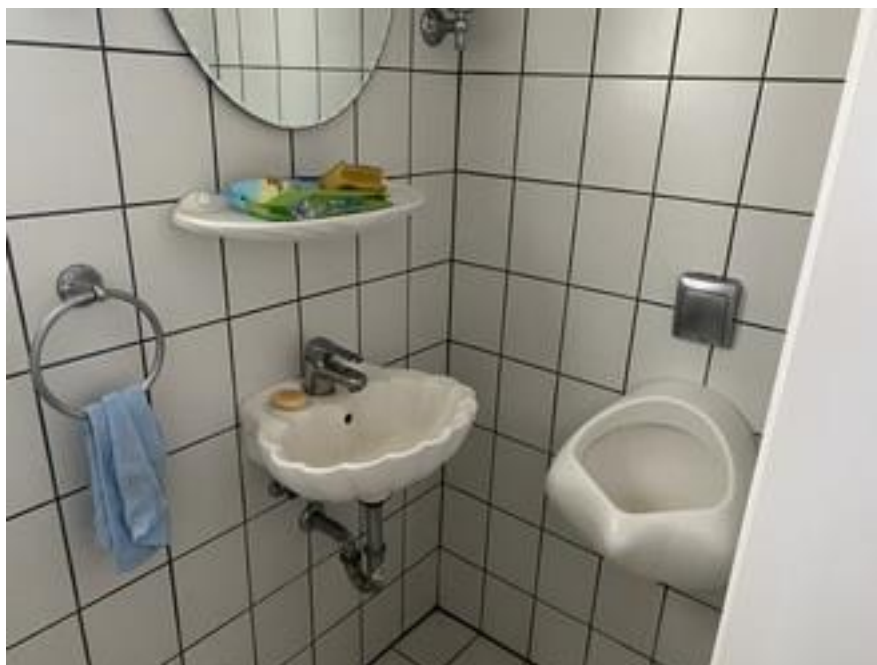
WB mit Einhebelmischer
