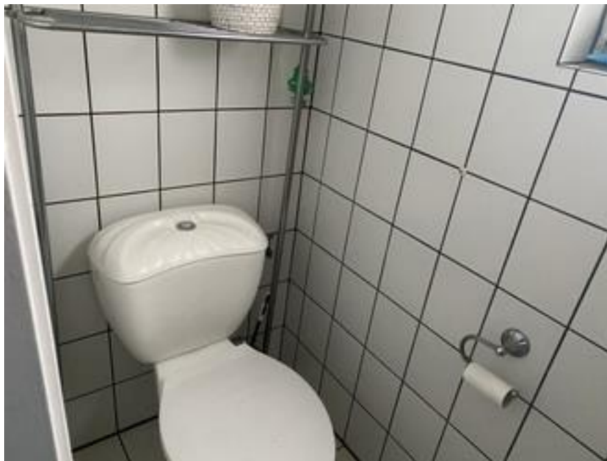
G-WC mit Stand-WC und aufgesetztem Keramikspülkasten
