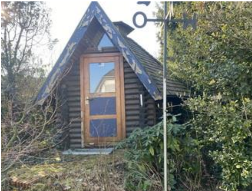
Gartenhaus 2, mit elt.-Heizung
