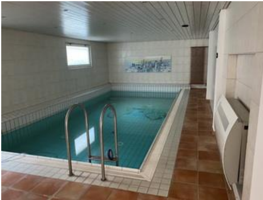
Schwimmbad, rechts ein Klimagerät
