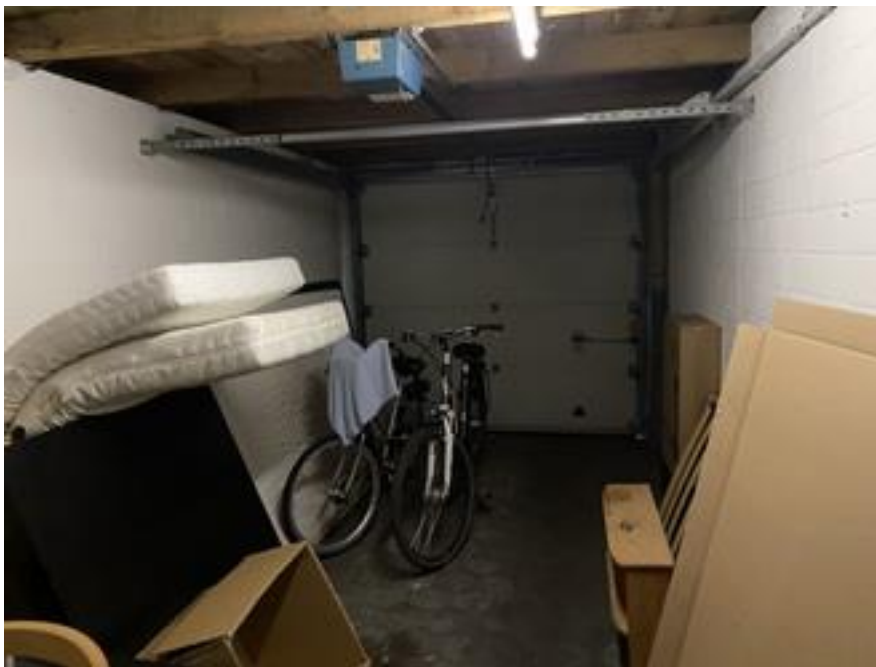
Innenansicht der rechten Garage, B.J. ca. 1987, gepflasterter Fußboden, Holzbalkendecke, elt, Torantrieb für Sektionaltor
