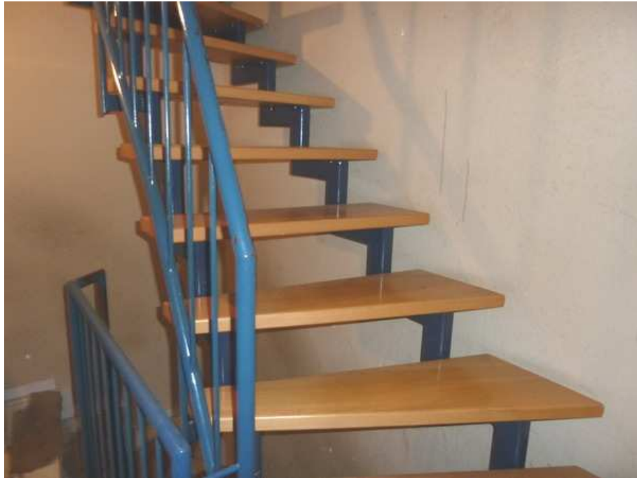
Treppe zum Spitzboden
