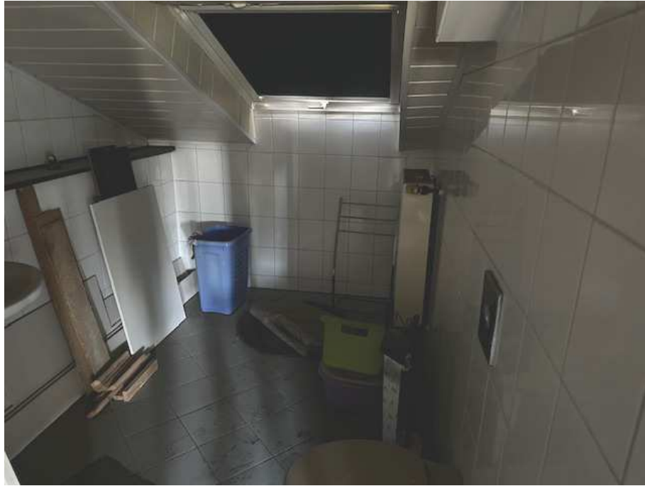
Bad im DG / Wohnhaus
