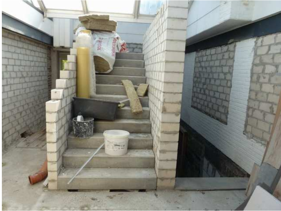
Treppenhaus im Anbau
