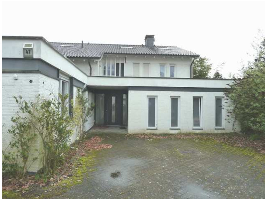
Grundstücksansicht aus Nordosten
