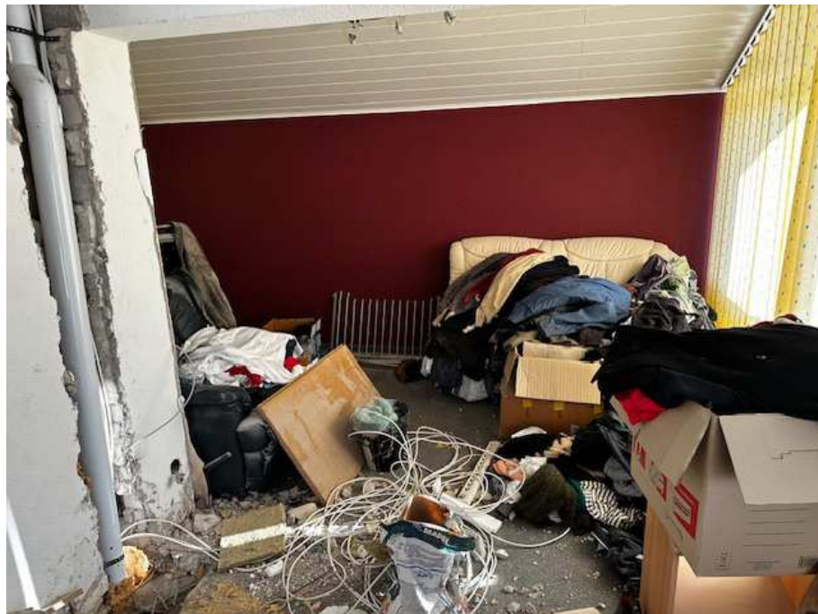
Kinderzimmer im OG / Wohngebäude
