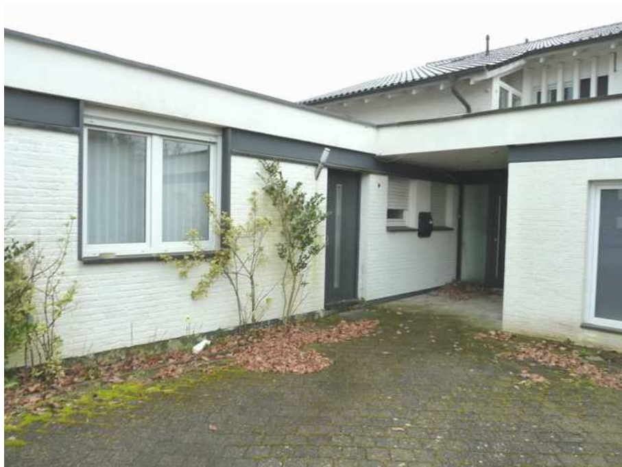
Grundstücksansicht aus Norden
