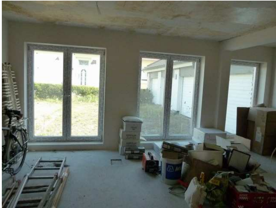
Ausbau ehemalige Praxis
