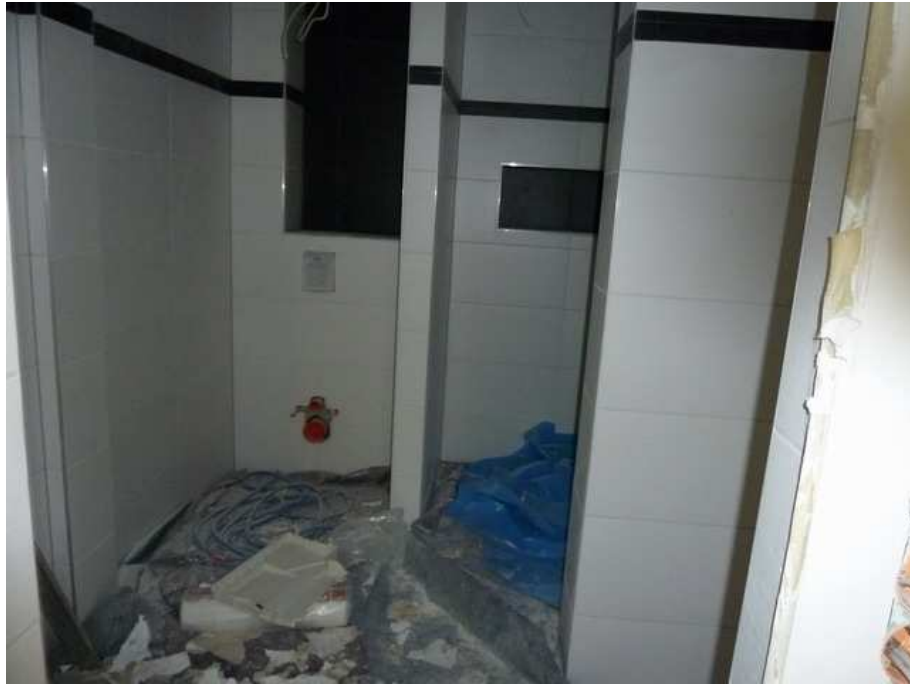
Ausbau Bad im EG ehemalige Praxis
