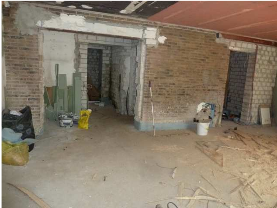
Kellerausbau ehemaliges Schwimmbad
