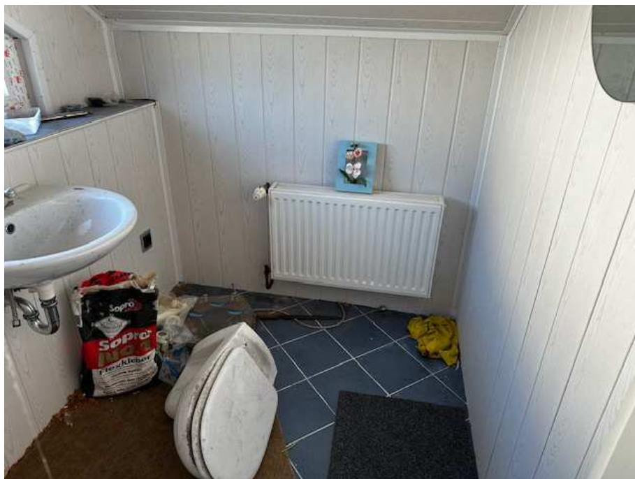
WC im Überbau Garage
