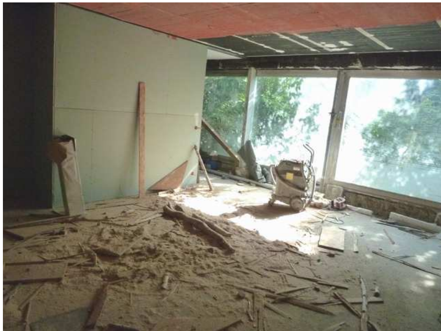
Kellerausbau ehemaliges Schwimmbad
