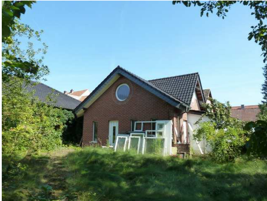
Lagergebäude an der südöstlichen Grundstücksgrenze
