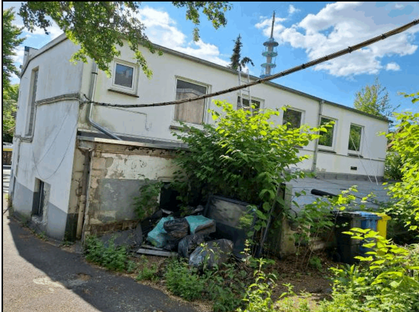
Foto 2: Rückseite Gebäude vorn
