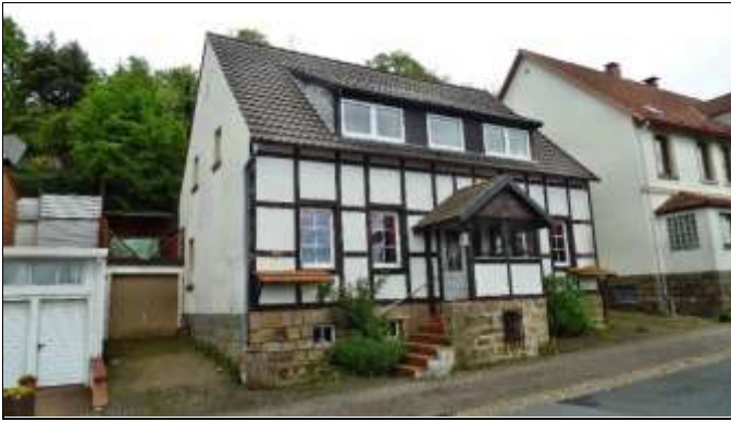
-1- Straßenansicht von Nordwesten
