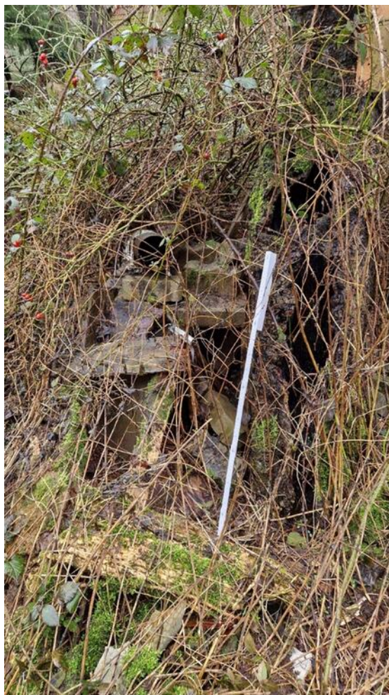
Abbildung 14: Flurstück 490. Stark überwachsene Ablagerungen von Betonplatten und Verbundpflastersteinen sowie Bauschutt. Datum der Aufnahme 14.02.2024.
