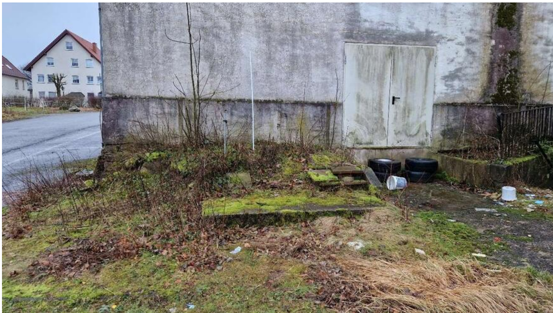
Abbildung 8: Flurstück 106 (Filleberg 3). Bereich der ehemaligen Eigenbedarfstankstelle. Datum der Aufnahme 14.02.2024.
