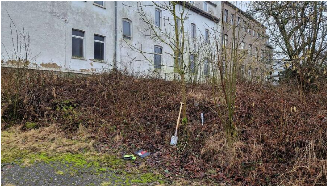
Abbildung 11: Flurstück 490. Böschung der Parkplatzfläche (Vordergrund). Standort des Spatenschurfs 1. Datum der Aufnahme 14.02.2024.
