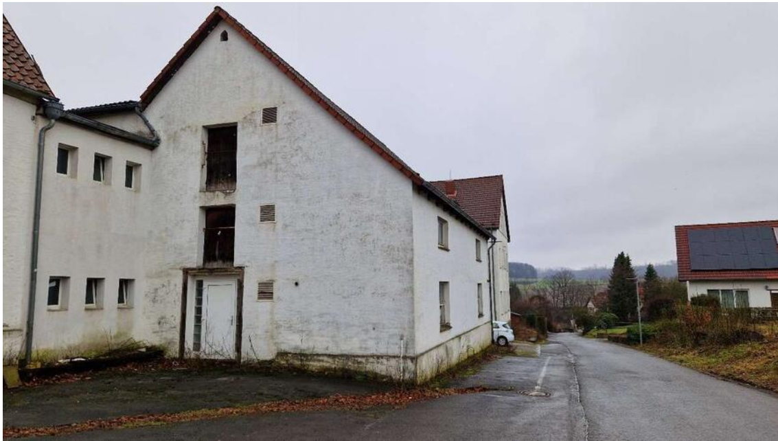
Abbildung 7: Außenbereich des Flurstücks 105 (Filleberg 1). Datum der Aufnahme 14.02.2024.
