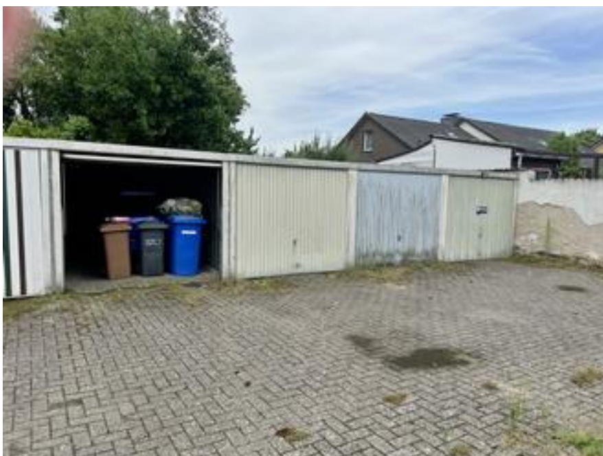
Stahlblechgarage auf Garagenhof (3. von rechts)
