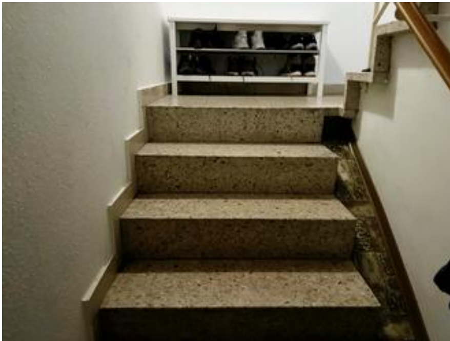
Kellertreppe, Beton mit Terrazzobelag
