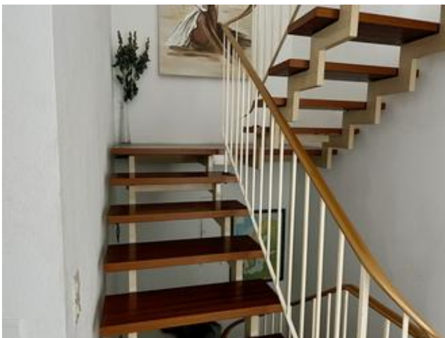
Holz-/Stahltrappe zum OG, Stahlgeländer mit Kunststoffhandlauf
