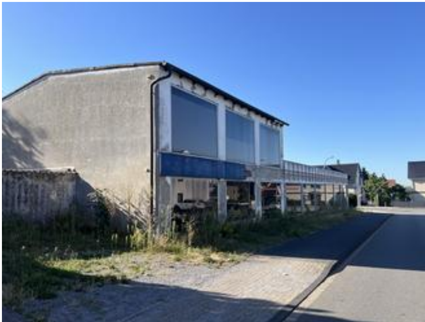
Straßenansicht wie vor, Norden
