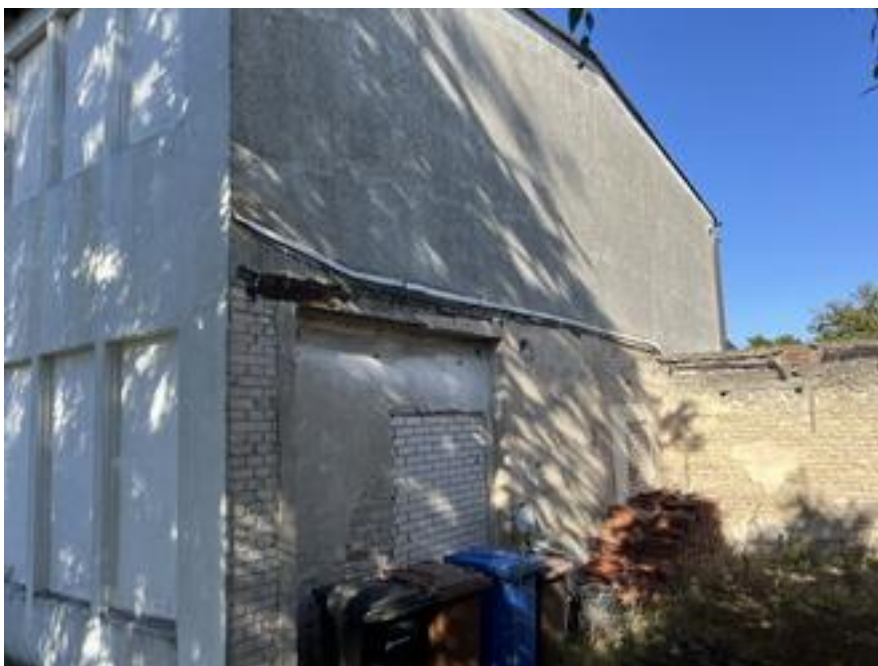
Hinterer 2-geschossiger Anbau, Nordosten
