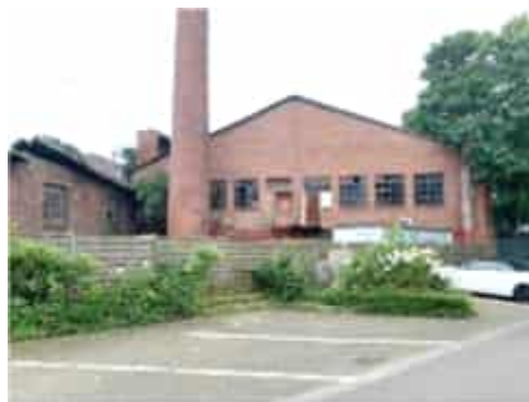
Gebäude am P & R Parkplatz (2)
