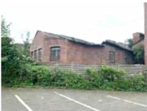
Gebäude am P & R Parkplatz (1)
