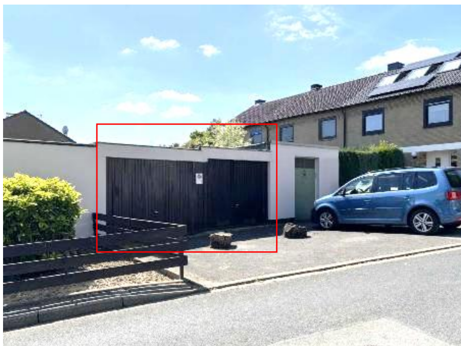
Garagen an der Eichendorffstraße
