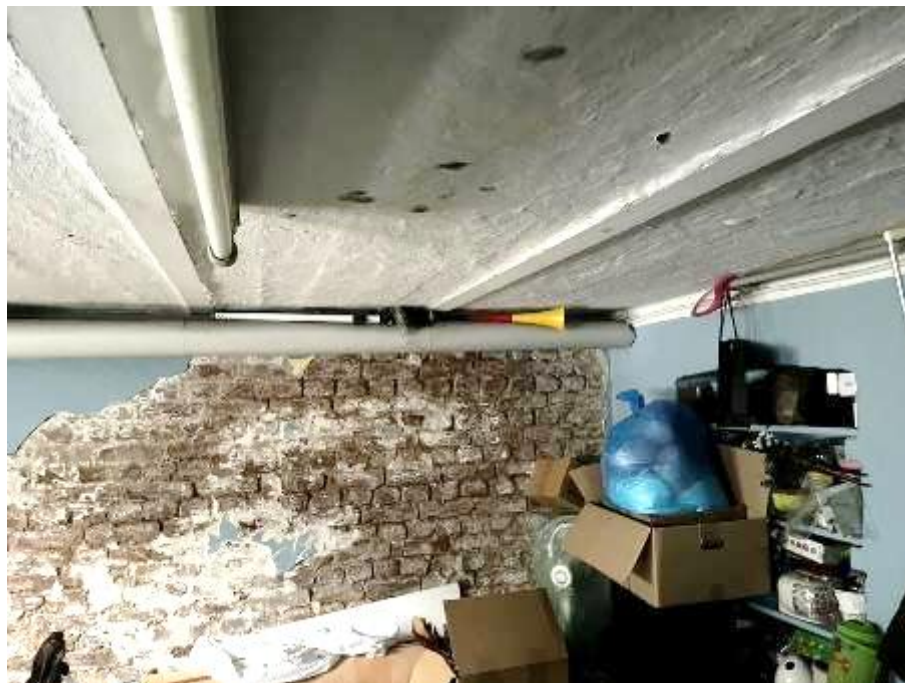
Feuchtigkeitsschäden Keller (1)
