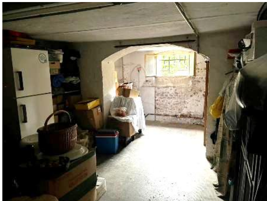
Feuchtigkeitsschäden Keller (2)
