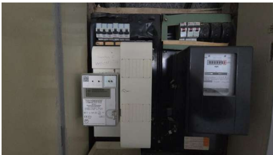
Sicherungsautomaten der Wohnungsunterverteilung und Zählertafel zu WE 9 (links) und WE 8 (rechts).
