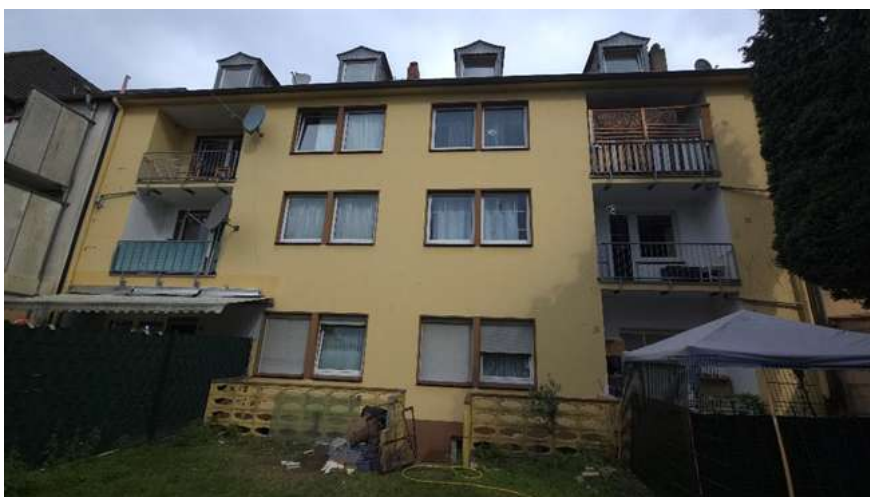
Gebäuderückseite mit Vermüllung im hinteren Grundstücksbereich.
