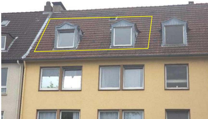
Straßenseitiger Blick auf die Fenster der WE 9. Erkennbar sind die starken Witterungsschäden an den Treppenhausfenstern mit Holzrahmen und Einfachverglasung, mitte links im Foto.
