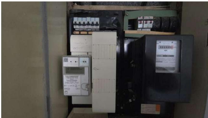
Sicherungsautomaten der Wohnungsunterverteilung und Zählertafel zu WE 8 (rechts).
