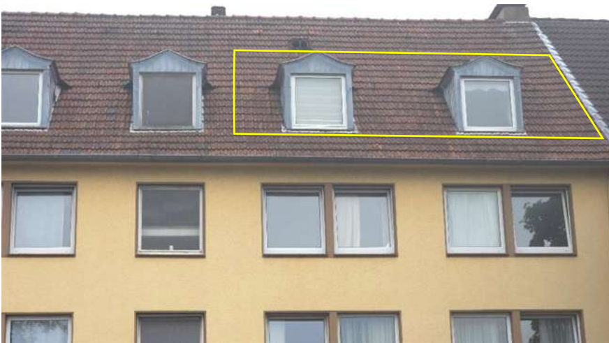
Straßenseitiger Blick auf die Fenster der WE 8. Erkennbar sind die starken Witterungsschäden an den Treppenhausfenstern mit Holzrahmen und Einfachverglasung, mitte links im Foto.
