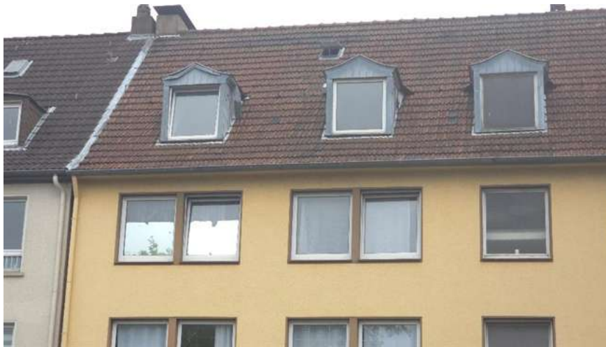
Straßenseitiger Blick auf die Fenster der WE 7. Erkennbar sind die starken Witterungsschäden an den Treppenhausfenstern mit Holzrahmen und Einfachverglasung, rechts im Foto.
