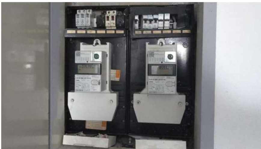
Sicherungsautomaten der Wohnungsunterverteilung und Zählertafel zu WE 7 (links).
