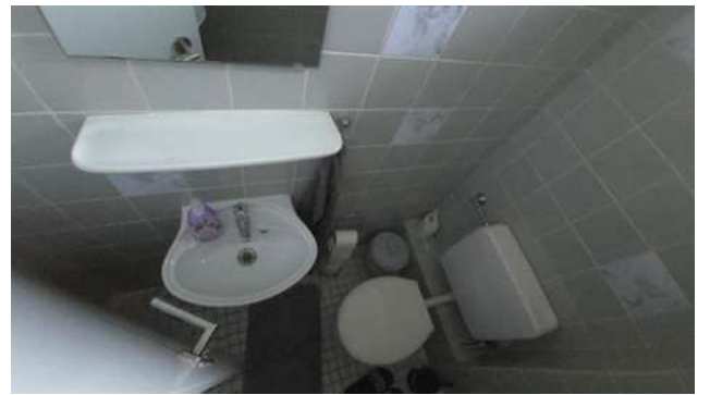
WE 2; WC-Raum im 1.OG.
