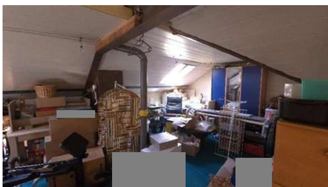
WE 4; teilweise ausgebauter Dachbodenraum.
