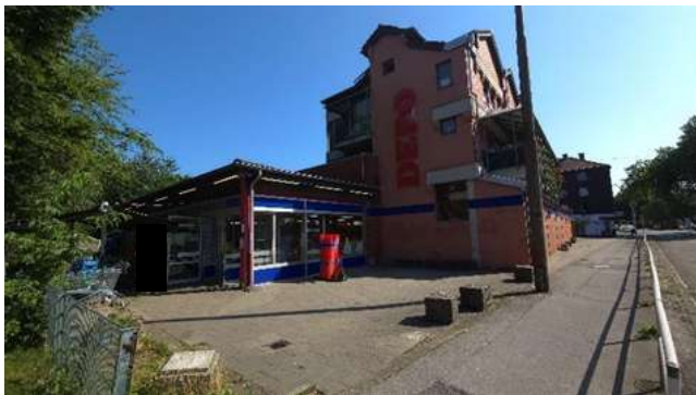
Zugang zum Ladenlokal von der Grenzstraße.
