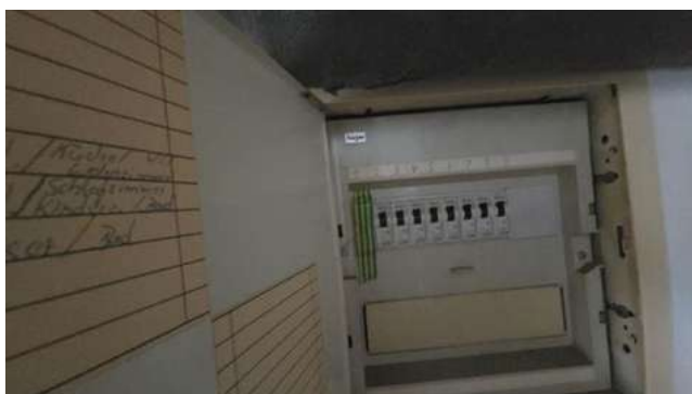
WE 6; Elektrounterverteilung.
