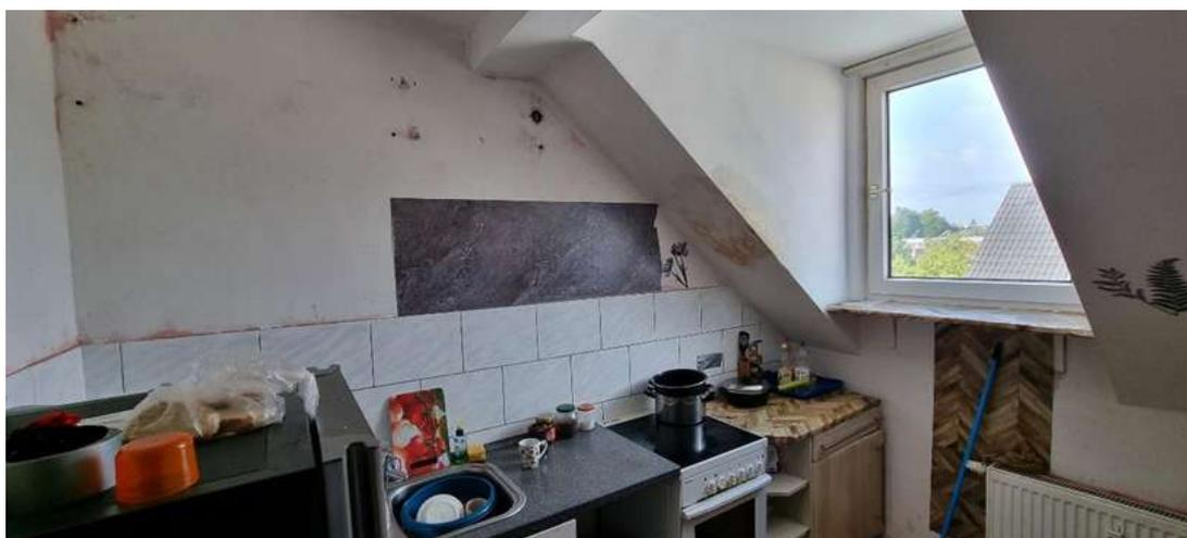
WE 5.2; Küche mit Feuchteschäden im Bereich der Dachschrägen.
