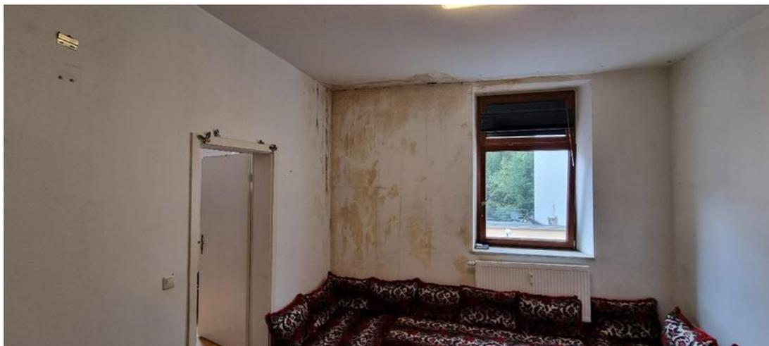
WE 3.1; straßenseitiges Durchgangszimmer mit Feuchtigkeitsschäden im Wand- und Deckenbereich.
