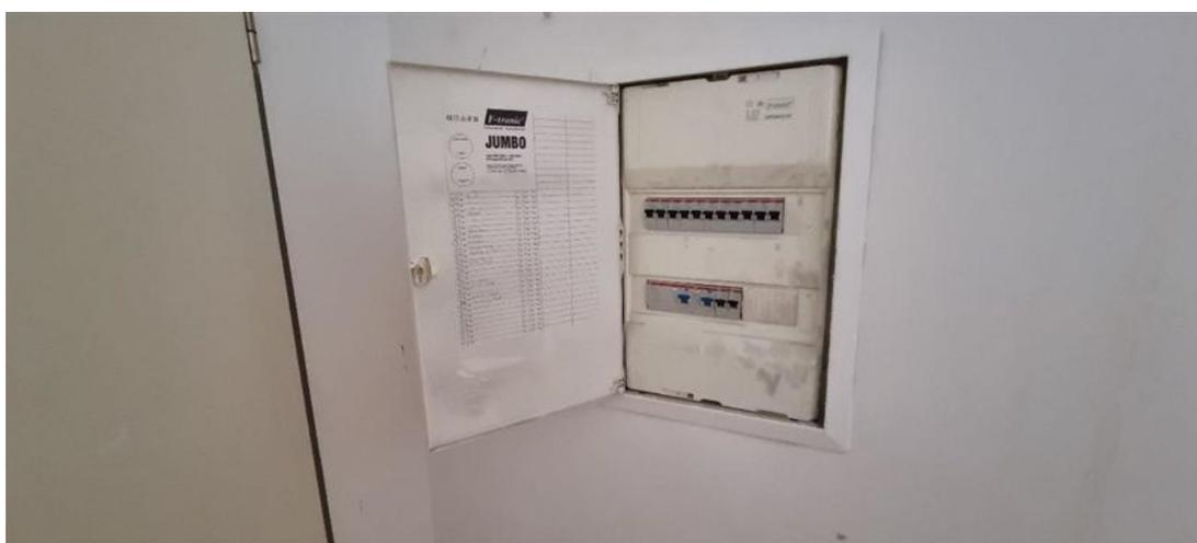
WE 3.1; Elektrounterverteilung mit Sicherungsautomaten im Flur.
