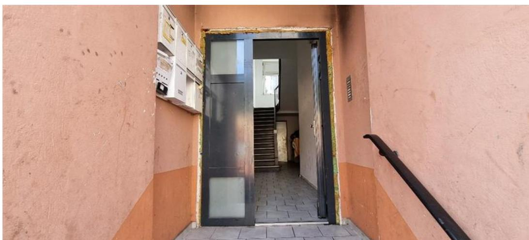
Hauseingangsbereich mit unvollständig eingefasster Haustüranlage und beschädigter Briefkastenanlage.
