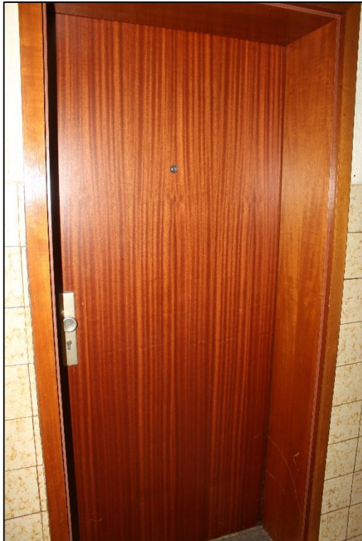
Foto Nr. 17: Gemeinschaftstreppenhaus, EG, Wohnungseingang vorne, WE Nr. 1
