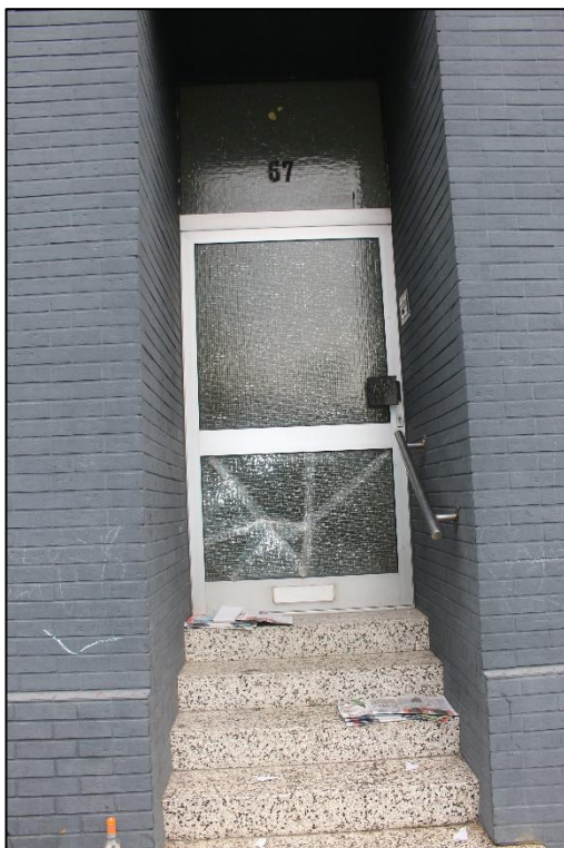
Foto Nr. 2: Hauseingang
