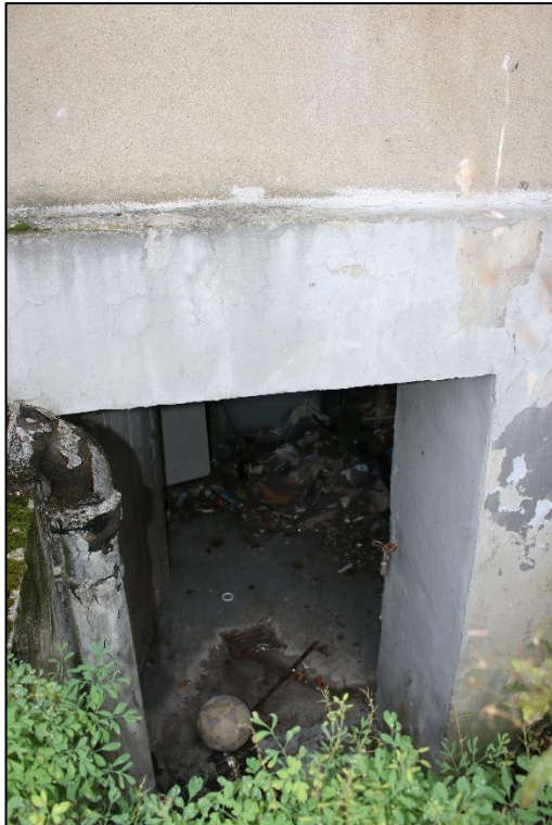
Foto Nr. 7: Kelleraußeneingang
