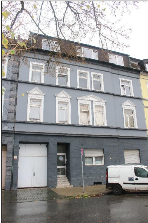
Foto Nr. 1: Straßenfassade
