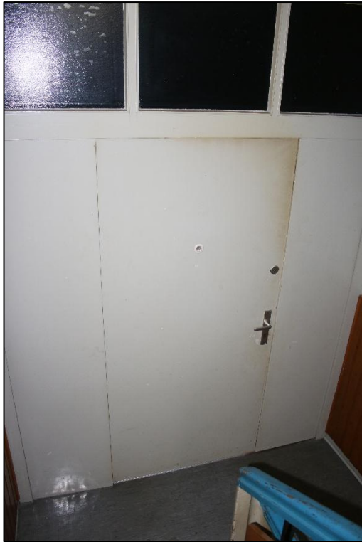
Foto Nr. 23: Gemeinschaftstreppenhaus, 1. OG, Wohnungseingang WE Nr. 3
