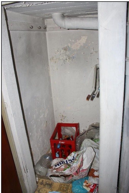
Foto Nr. 24: Gemeinschaftstreppenhaus, Treppenpodest zum 2. OG, Abstellraum
