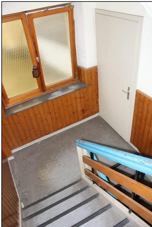
Foto Nr. 21: Gemeinschaftstreppenhaus, EG, Treppenhause zum 1. OG
