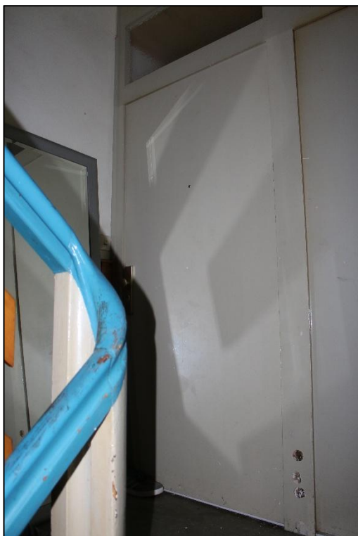
Foto Nr. 26: Gemeinschaftstreppenhaus, 2. OG, Wohnungseingang links, WE Nr. 5
