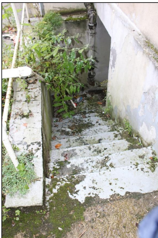
Foto Nr. 6: Kelleraußeneingang
