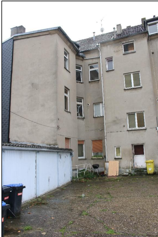
Foto Nr. 3: Hoffassade
