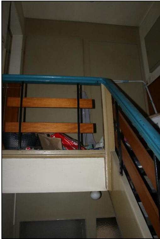
Foto Nr. 29: Gemeinschaftstreppe, DG
