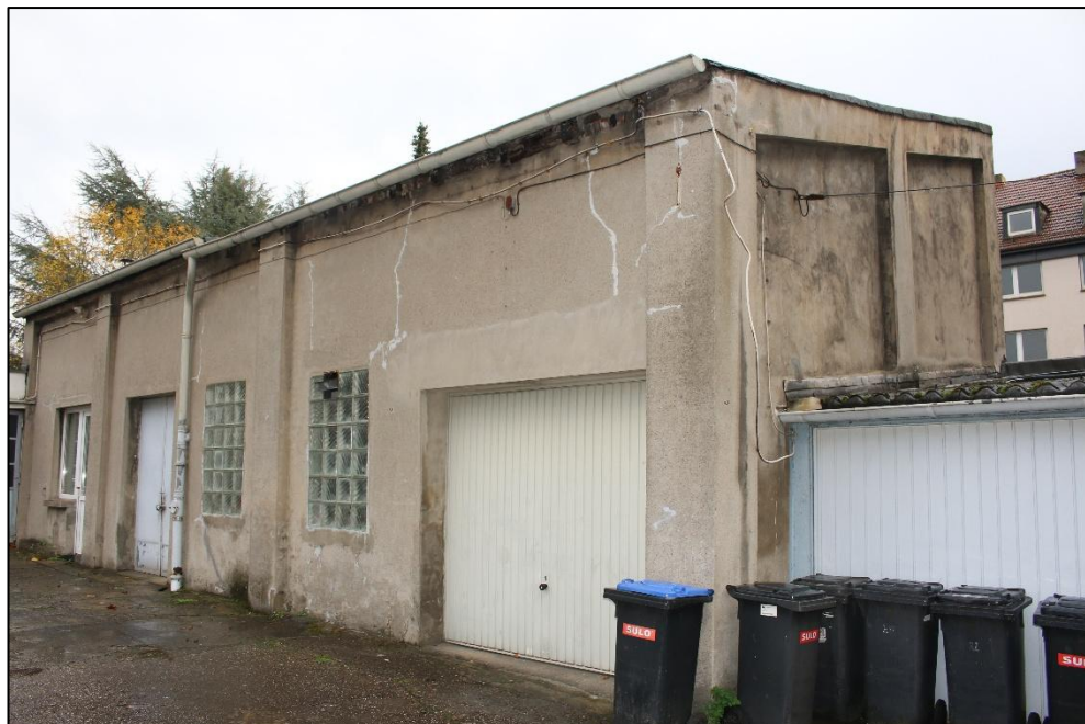
Foto Nr. 10: Nebengebäude 1
