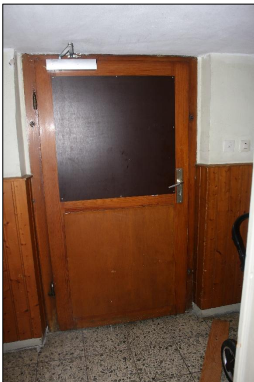
Foto Nr. 14: Gemeinschaftstreppe, EG, Hofausgang
