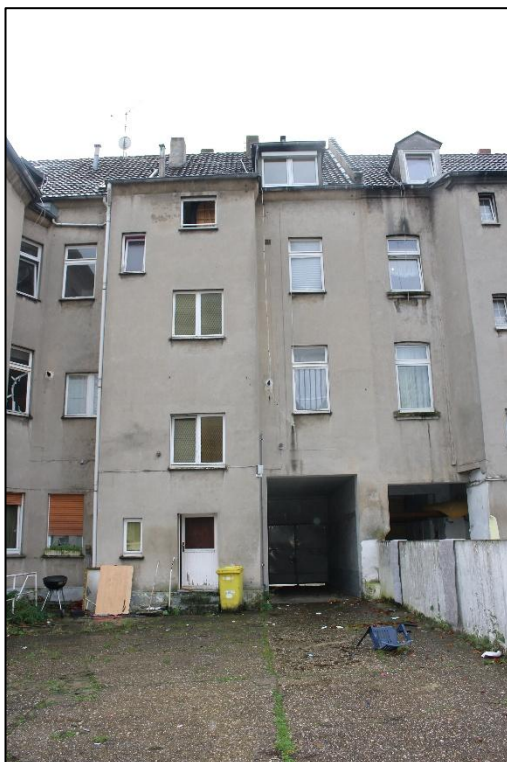
Foto Nr. 4: Hoffassade
