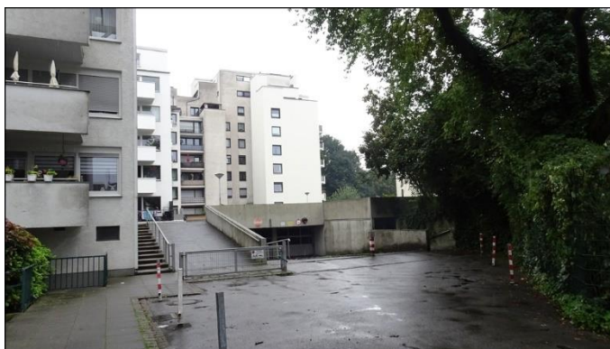
1) Aufgang zu den Hauseingängen/ Zufahrt Tiefgarage und Tiefgargendach
