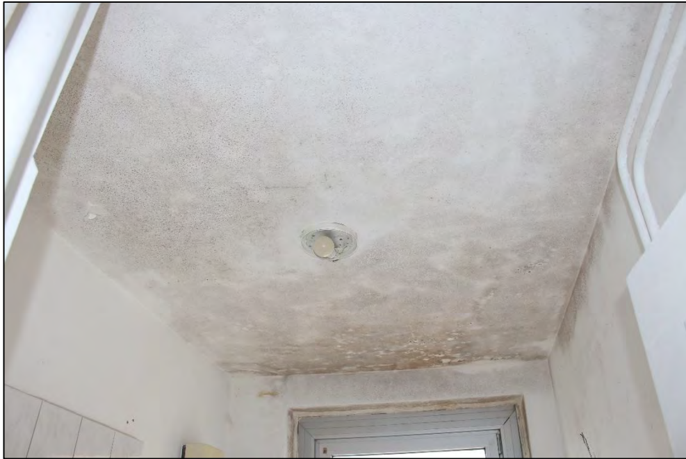
Foto Nr. 51: WE Nr. 3, 1. OG links, Küche
