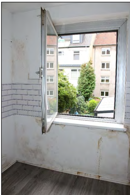
Foto Nr. 50: WE Nr. 3, 1. OG links, Küche
