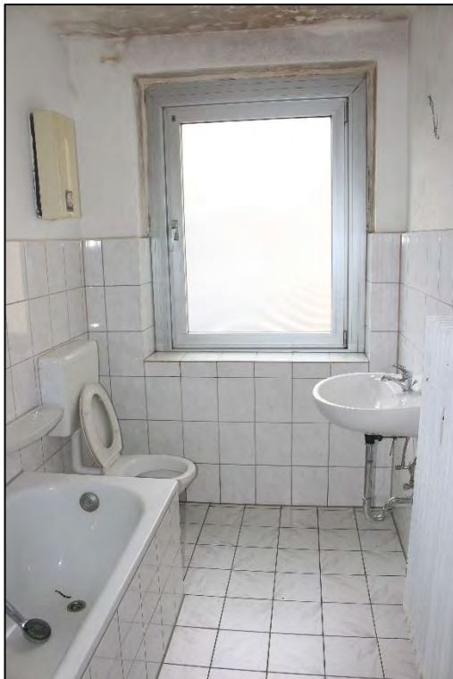
Foto Nr. 52: WE Nr. 3, 1. OG links, Bad
