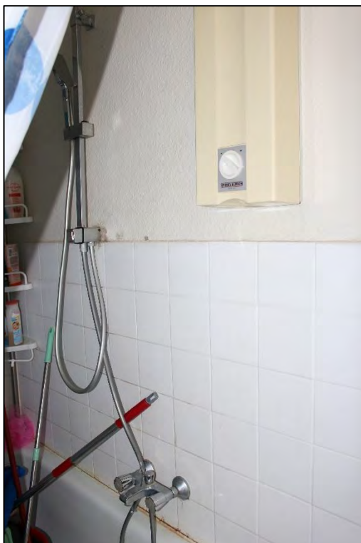
Foto Nr. 68: WE Nr. 5, 2. OG links, Bad
