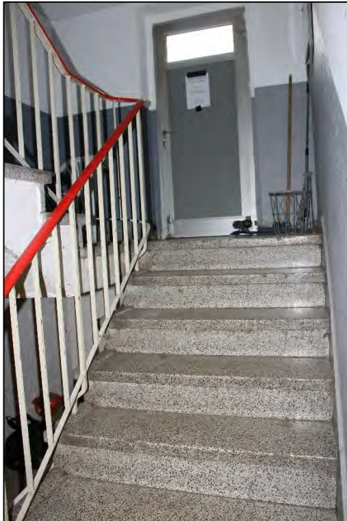
Foto Nr. 13: Treppe zum Kellerabgang, Hofausgang
