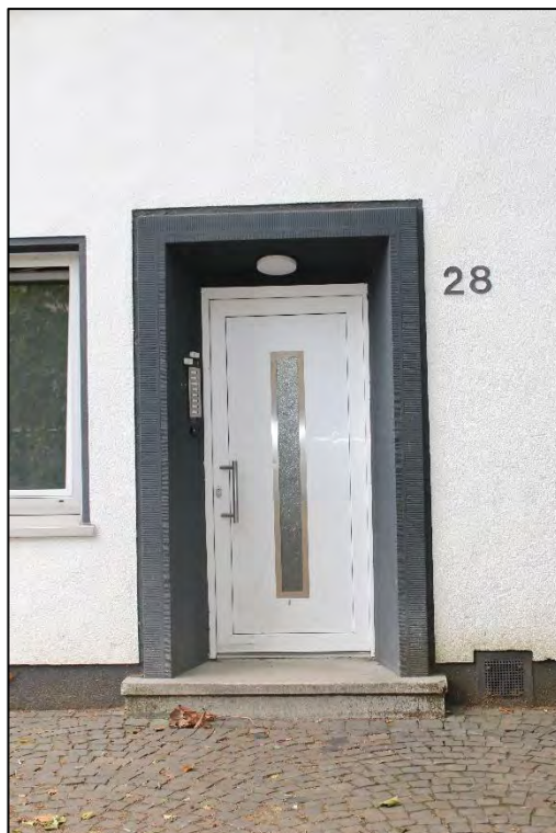
Foto Nr. 2: Hauseingang
