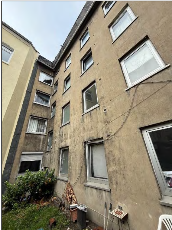
Foto Nr. 5: Hoffassade
