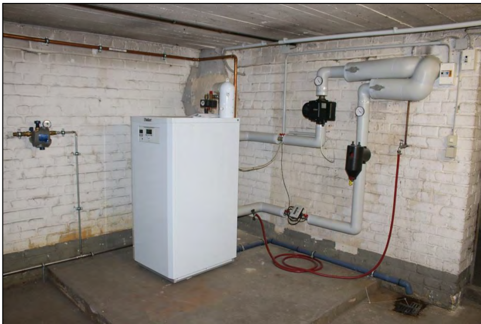
Foto Nr. 17: Kellergeschoss, Heizungsraum
