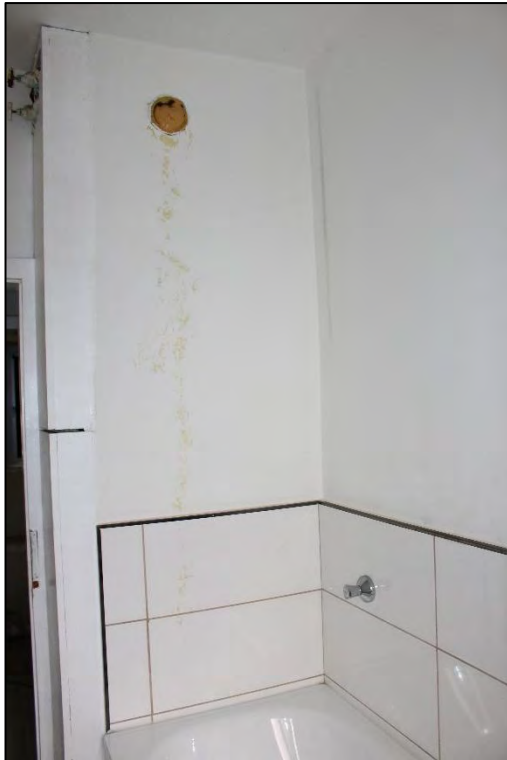
Foto Nr. 27: WE Nr. 1, EG links, Bad
