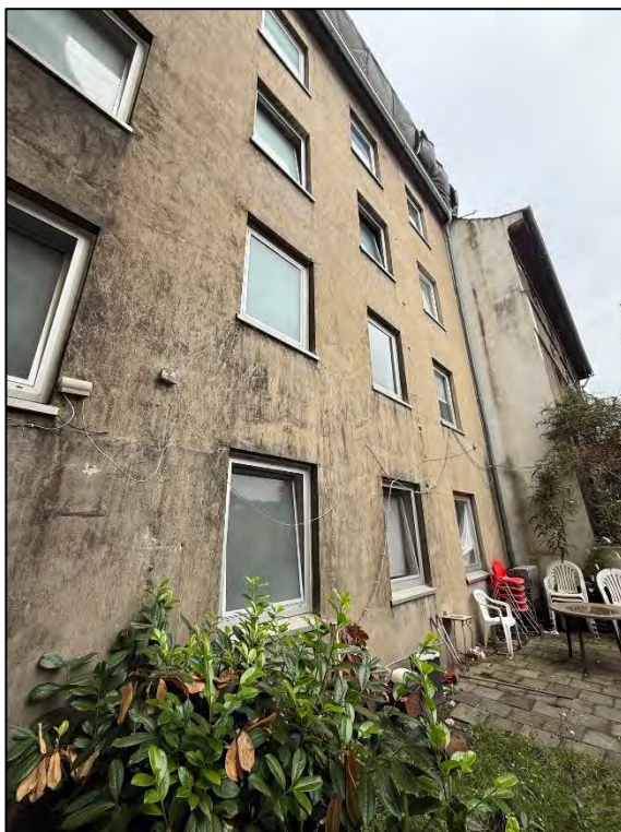
Foto Nr. 4: Hoffassade
