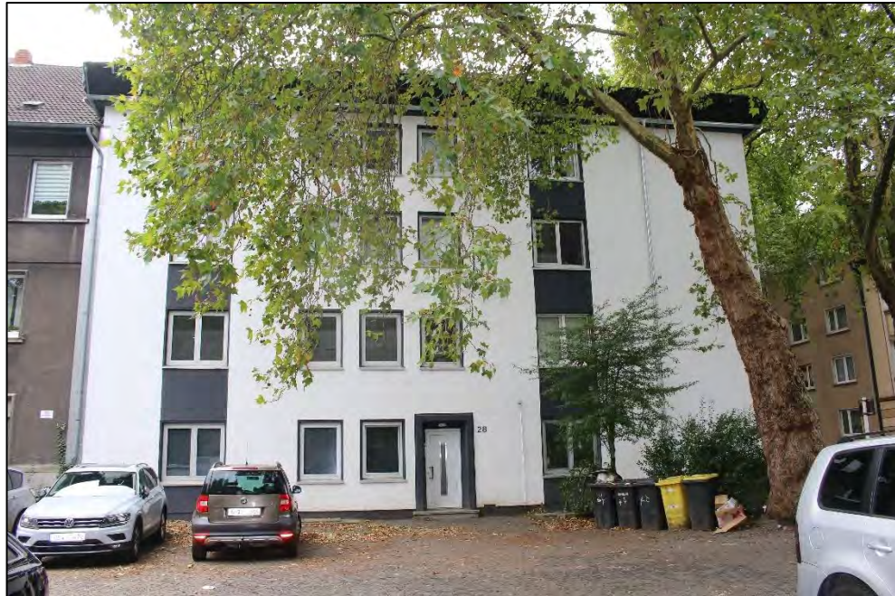
Foto Nr. 1: Eingangsfassade
