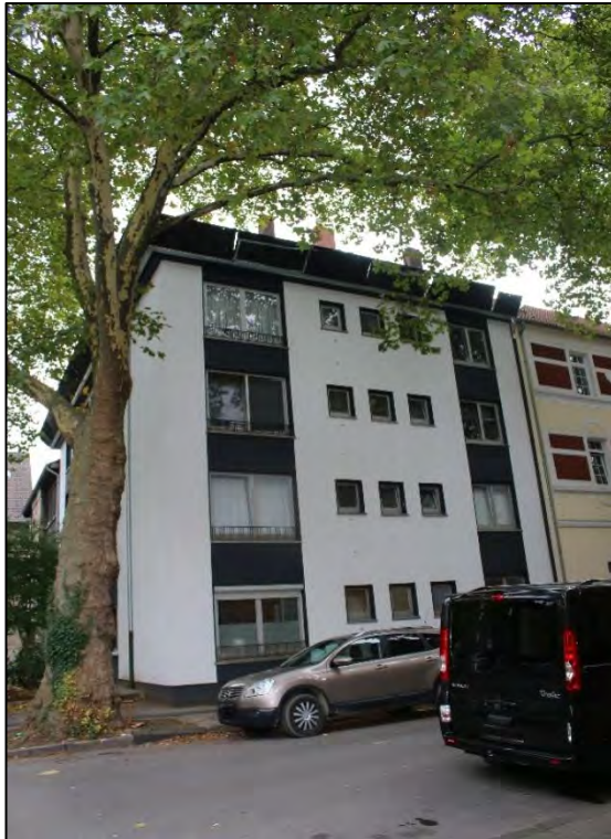
Foto Nr. 3: Straßenfassade
