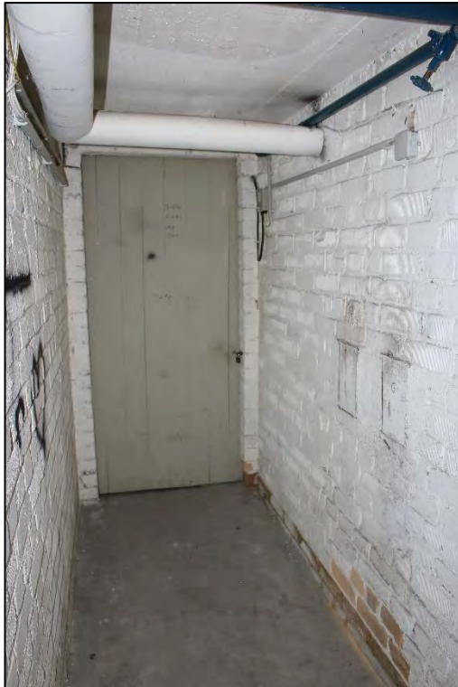
Foto Nr. 19: Kellergeschoss, Flur
