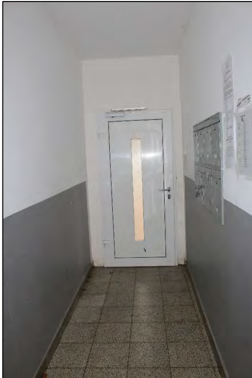
Foto Nr. 11: Gemeinschaftstreppe, EG, Hauseingang
