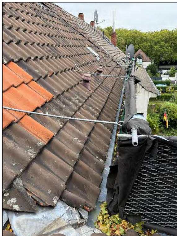
Foto Nr. 110: Dachfläche
