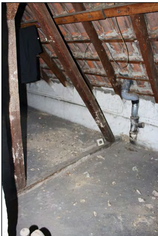
Foto Nr. 108: Dachboden
