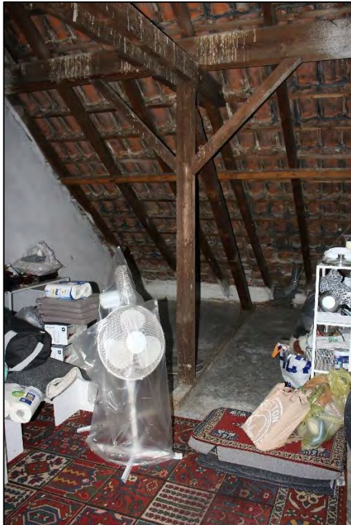
Foto Nr. 107: Dachboden
