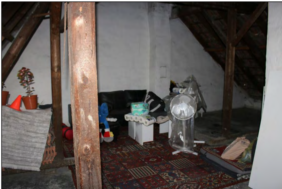
Foto Nr. 104: Dachboden
