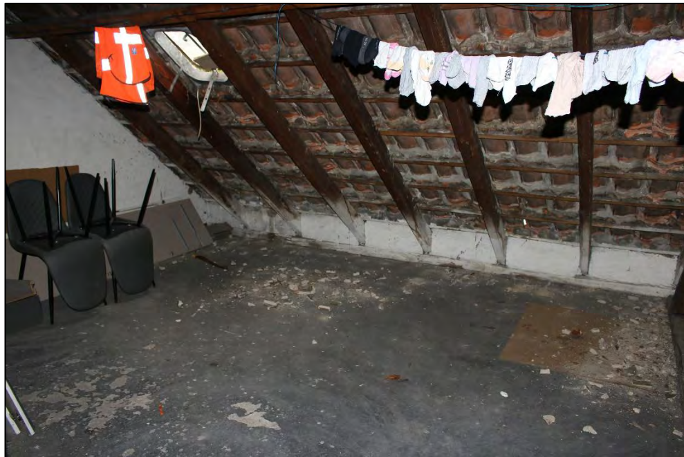
Foto Nr. 109: Dachboden
