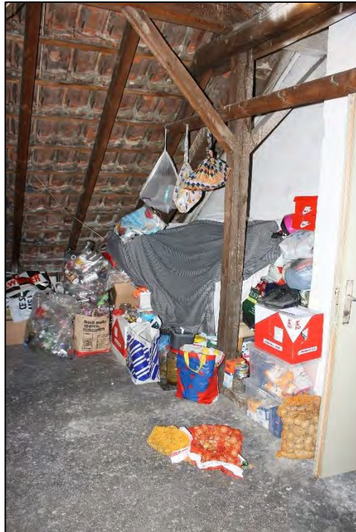
Foto Nr. 105: Dachboden
