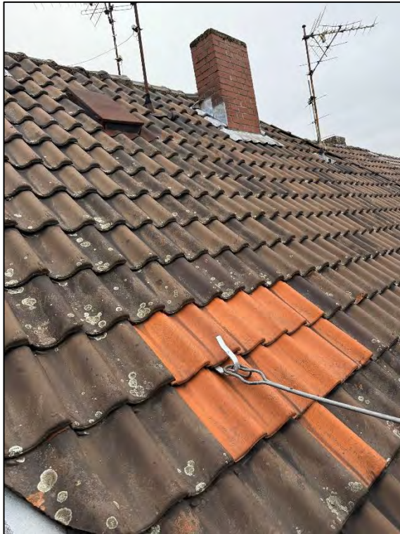
Foto Nr. 111: Dachfläche
