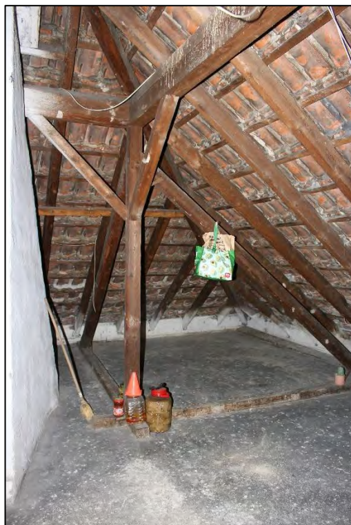
Foto Nr. 106: Dachboden
