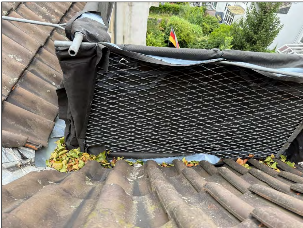
Foto Nr. 112: Dachfläche
