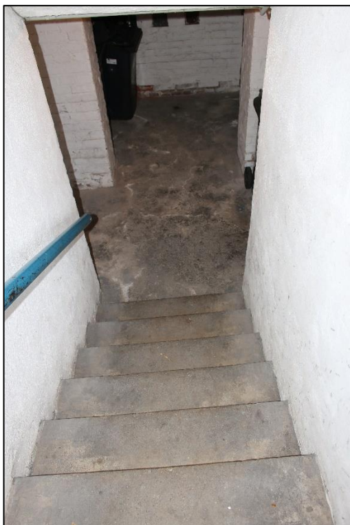
Foto Nr. 20: Treppe zum Kellergeschoss
