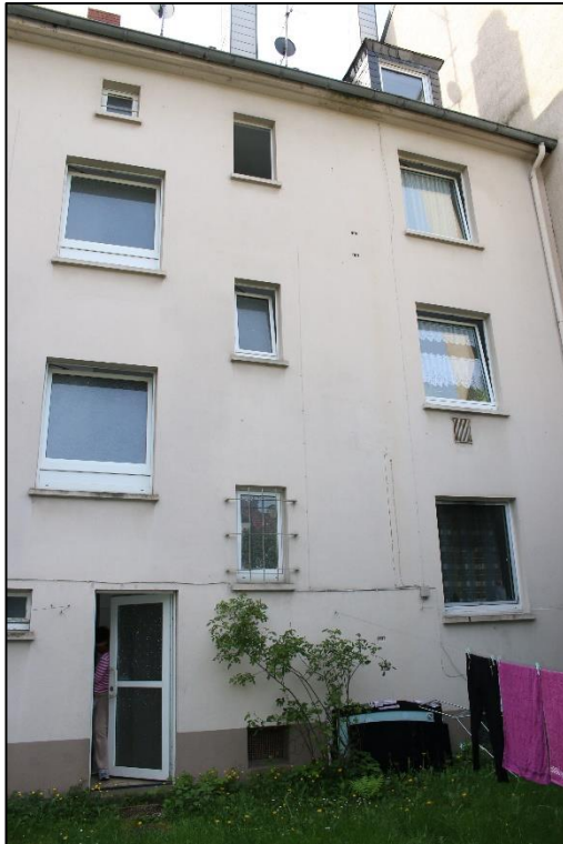
Foto Nr. 5: Hoffassade
