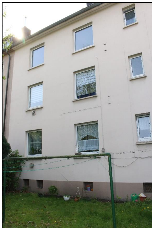
Foto Nr. 4: Hoffassade
