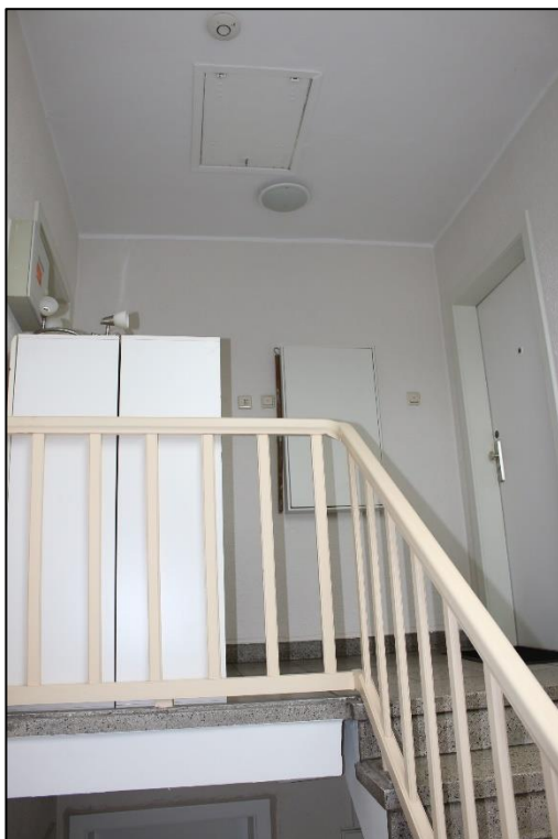
Foto Nr. 12: Gemeinschaftstreppenhaus, Dachgeschoss
