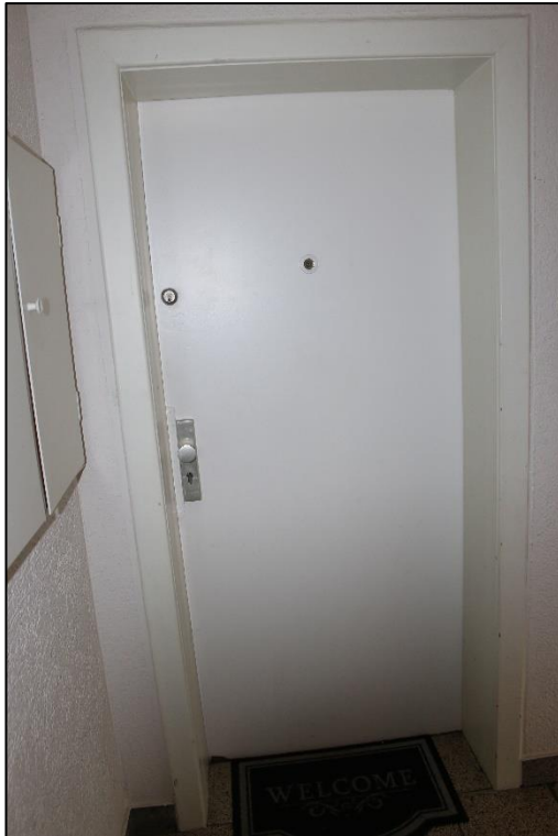
Foto Nr. 11: Gemeinschaftstreppenhaus, 1. OG links, Eingang ETW Nr. 3
