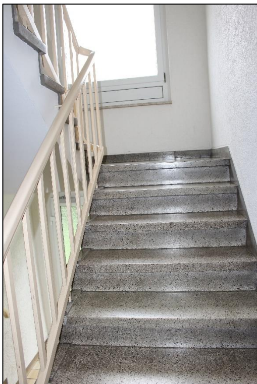
Foto Nr. 10: Gemeinschaftstreppenhaus
