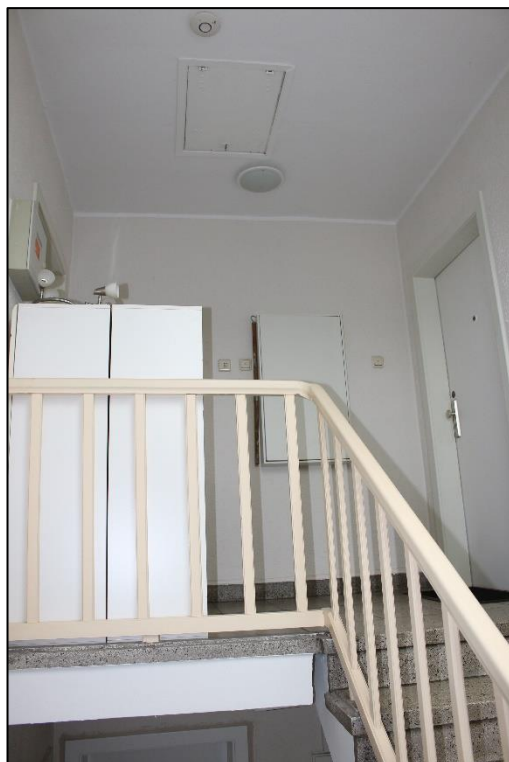
Foto Nr. 18: Gemeinschaftstreppe, Dachgeschoss
