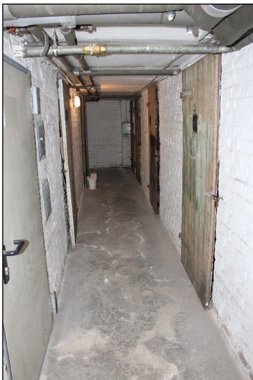
Foto Nr. 24: Kellergeschoss, Flur
