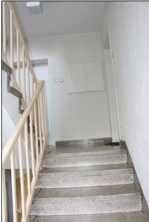
Foto Nr. 19: Gemeinschaftstreppehaus
