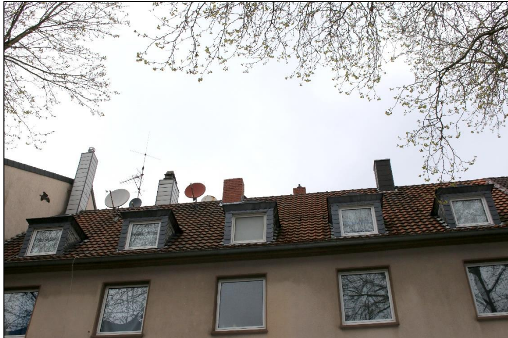
Foto Nr. 3: Dachfläche
