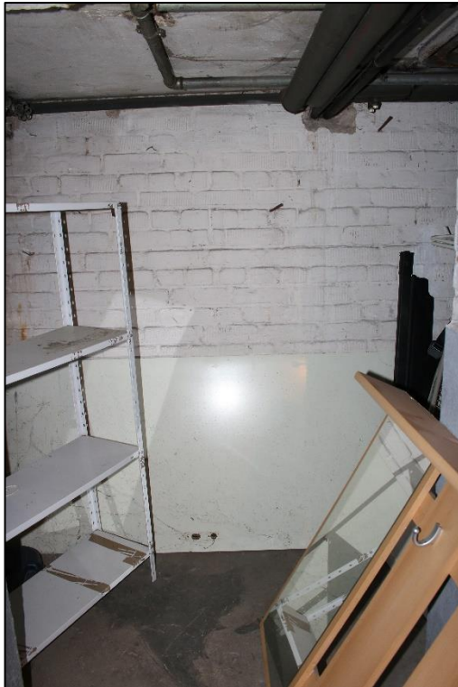
Foto Nr. 23: Kellergeschoss, Waschküche / Abstellraum
