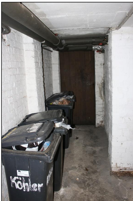
Foto Nr. 22: Kellergeschoss, Flur
