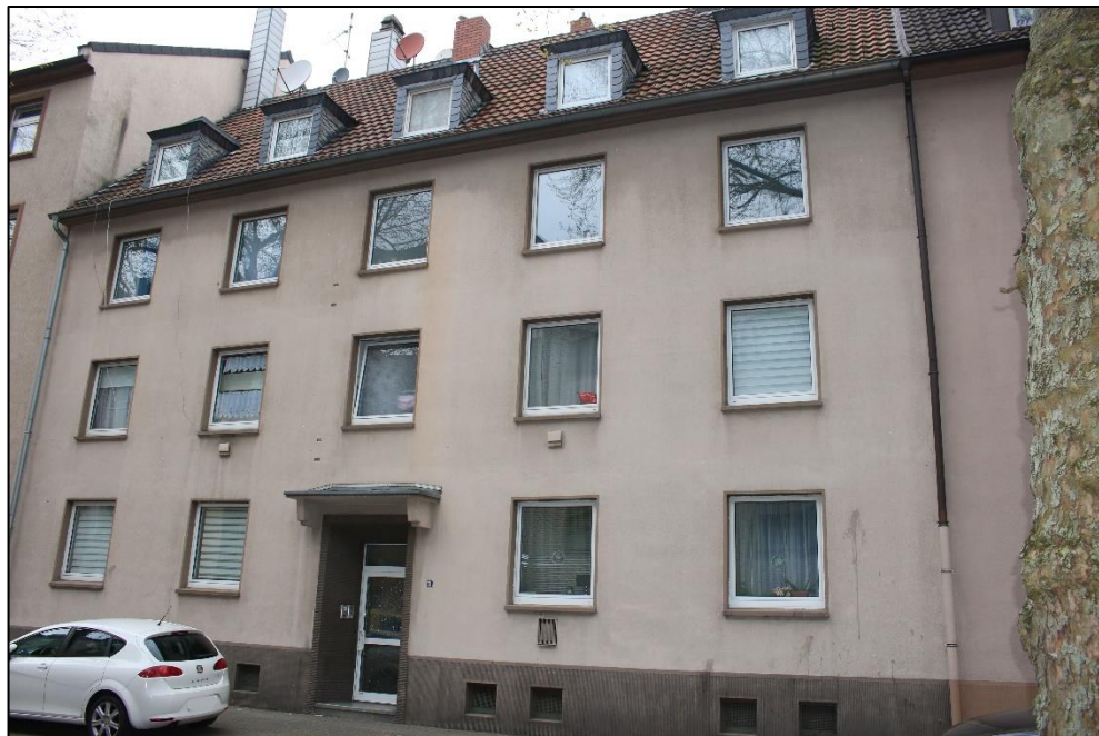
Foto Nr. 1: Straßenfassade
