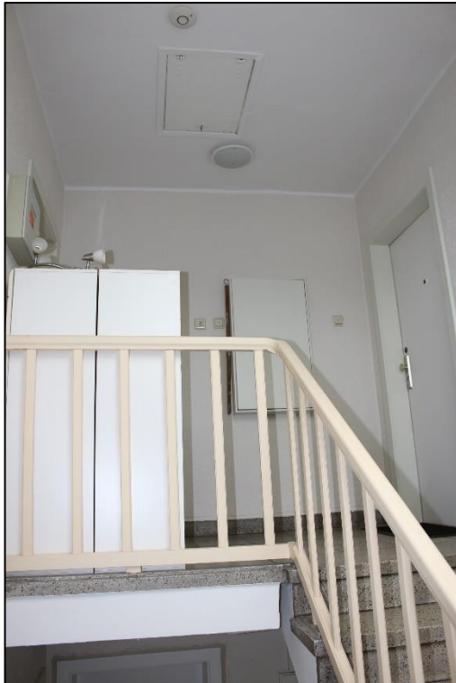
Foto Nr. 19: Gemeinschaftstreppenhaus, Dachgeschoss
