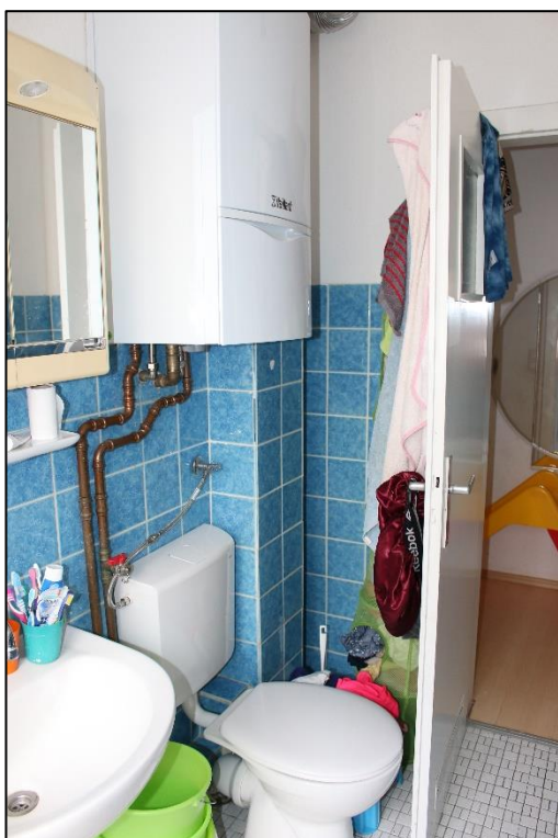
Foto Nr. 18: ETW Nr. 4 im 1. OG mittig, Bad
