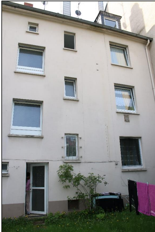
Foto Nr. 5: Hoffassade
