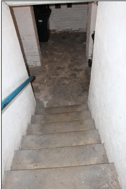
Foto Nr. 21: Treppe zum Kellergeschoss
