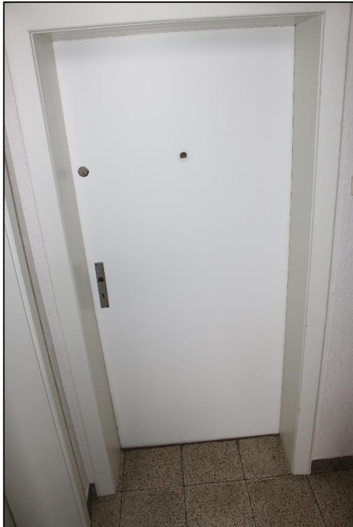
Foto Nr. 11: Gemeinschaftstreppenhaus, 1. OG mittig, Eingang ETW Nr. 4
