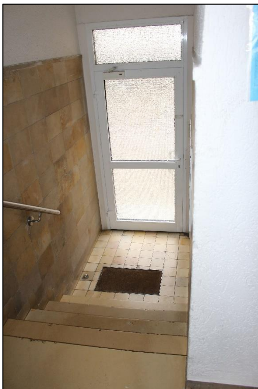
Foto Nr. 8: Gemeinschaftstreppe, Erdgeschoss, Hauseingang
