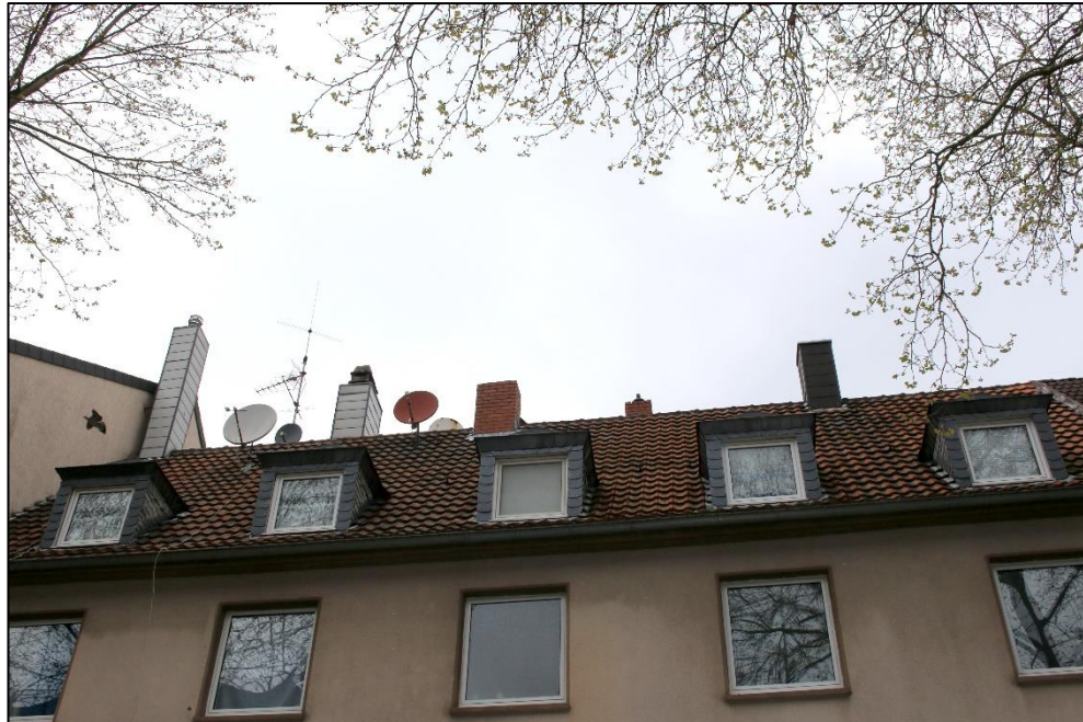
Foto Nr. 3: Dachfläche
