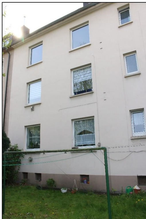
Foto Nr. 4: Hoffassade
