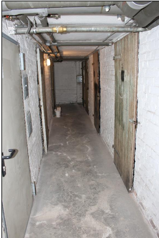
Foto Nr. 25: Kellergeschoss, Flur
