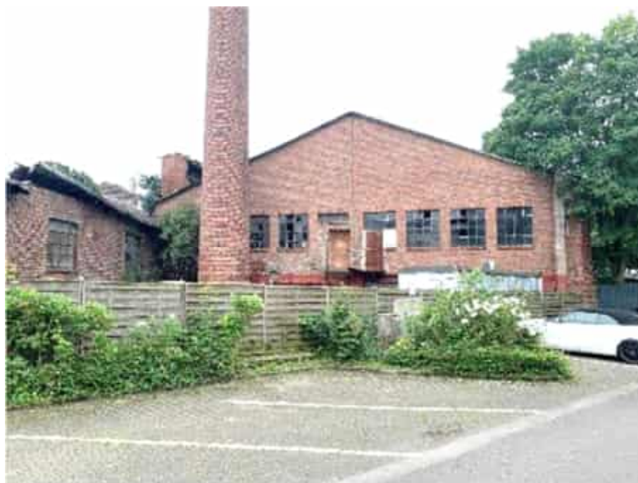
Ansicht vom Park-und-Ride Parkplatz S-Bahn
