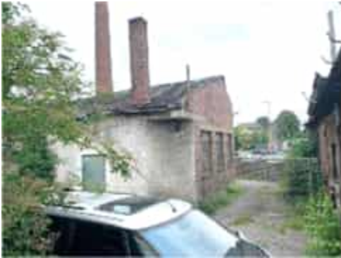
Blick in den Innenbereich (3)
