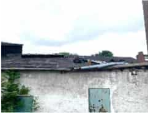
Blick in den Innenbereich (1)
