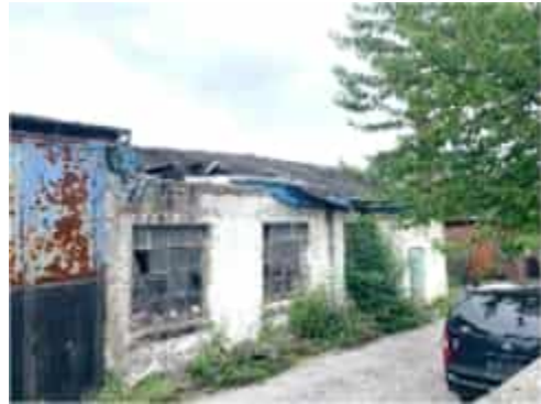
Blick in den Innenbereich (4)
