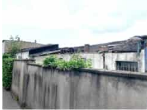
Blick in den Innenbereich (2)
