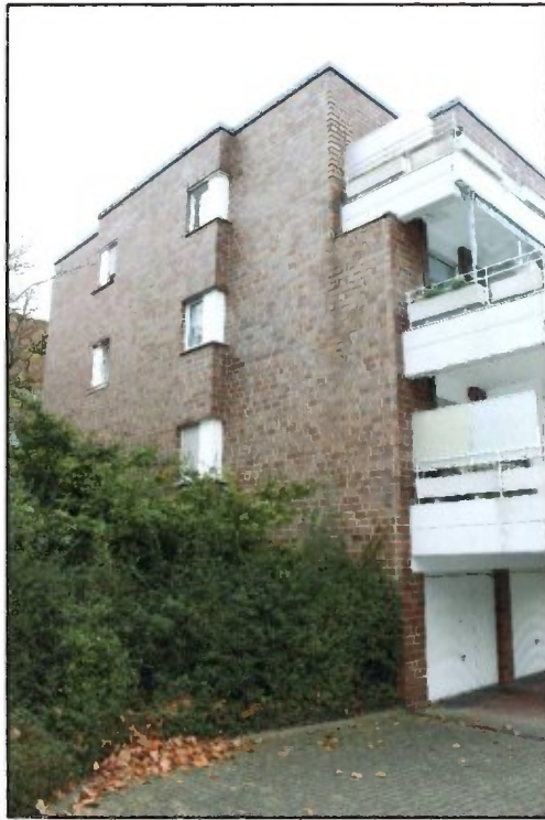
Foto Nr. 11: Seitenfassade
