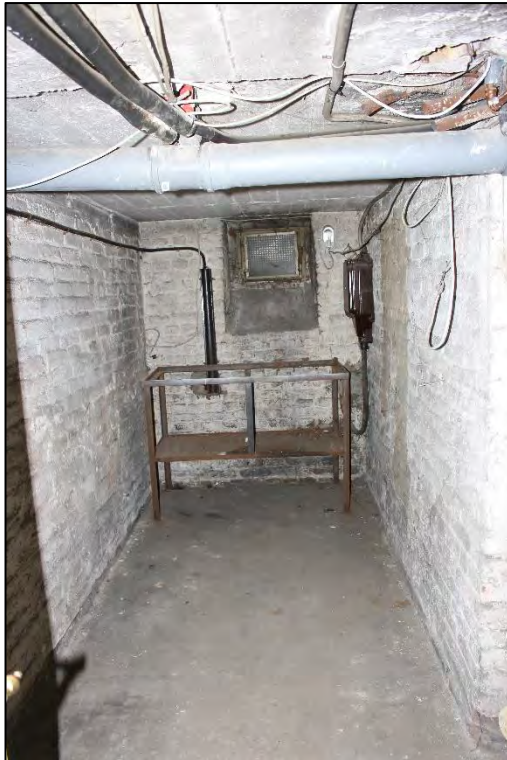
Foto Nr. 17: Kellergeschoss, Stromhausanschluss
