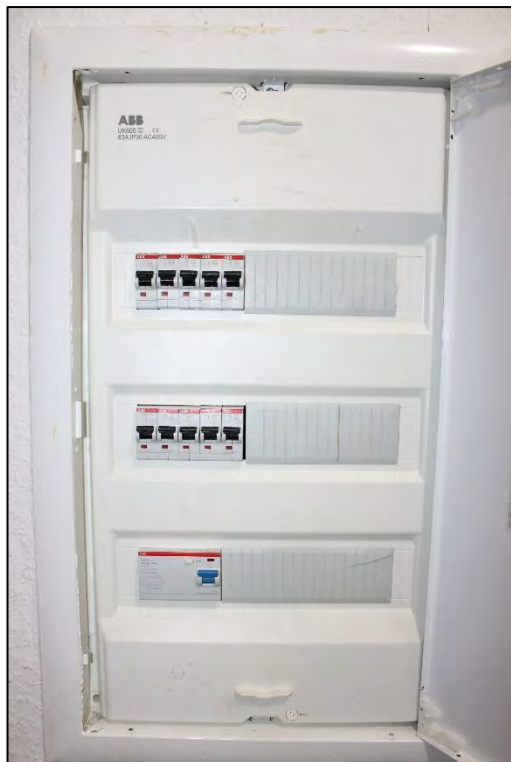
Foto Nr. 25: 3. OG rechts, ETW Nr. 7, Elektrounterverteilung
