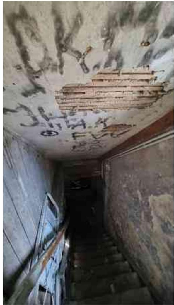
Zugang ins Kellergeschoss mit Putzschäden im Wand- und Deckenbereich.
