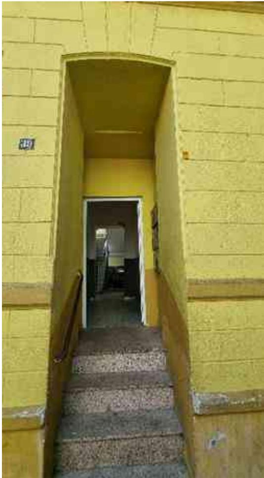
Hauseingangsbereich mit Putzschäden an der Fassade.
