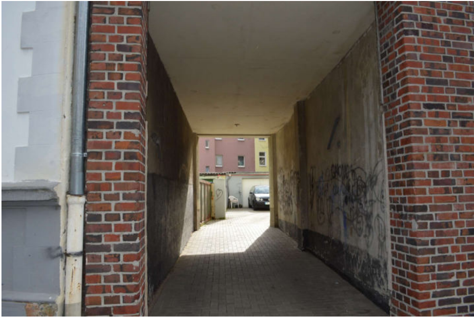
Bild 5: Zugang zum Grundstück
