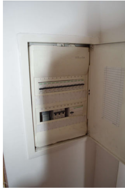
Bild 14: Sicherungskasten
