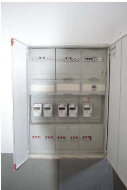
Bild 15: Zählerschrank
