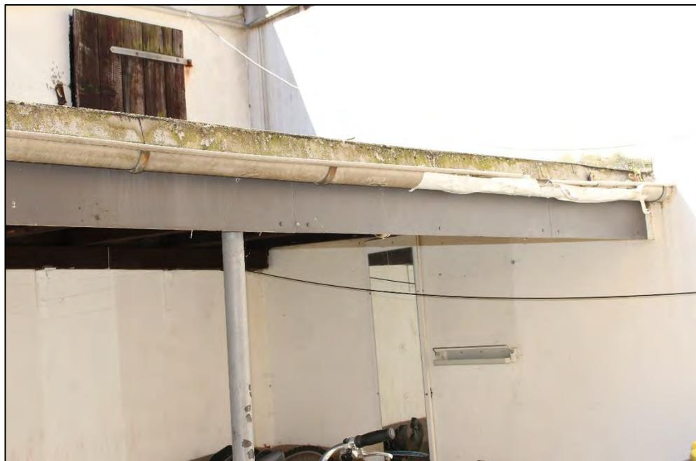
Foto Nr. 12: Überdachung, schadhafte Dachentwässerung
