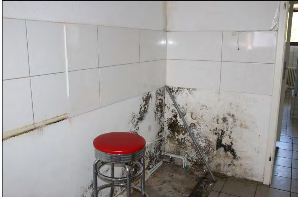
Foto Nr. 113: WE Nr. 4, Dachgeschoss rechts, Küche / Feuchteschäden
