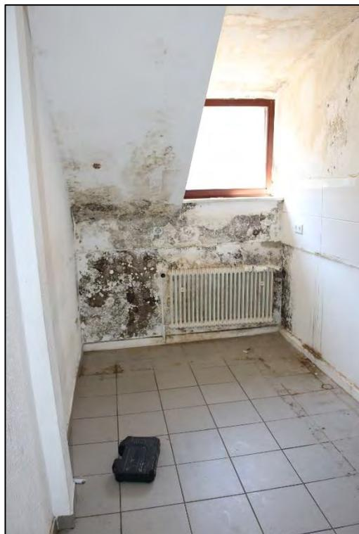
Foto Nr. 112: WE Nr. 4, Dachgeschoss rechts, Küche / Feuchteschäden
