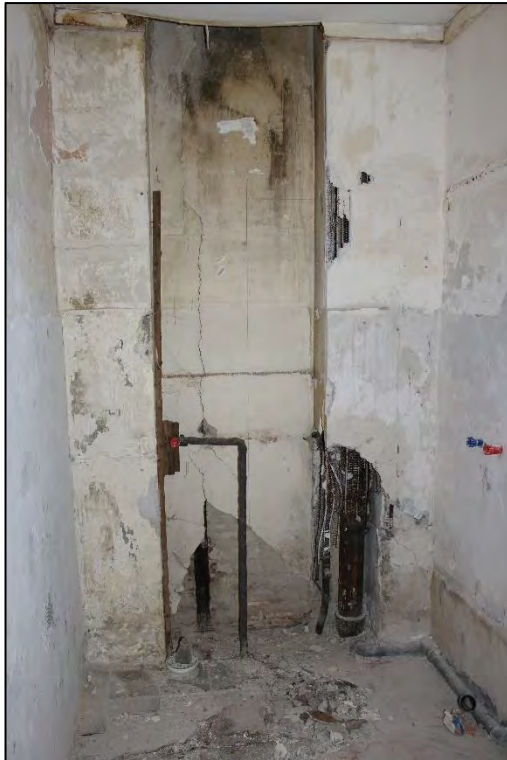
Foto Nr. 77: Anbau, Erdgeschoss, Bad
