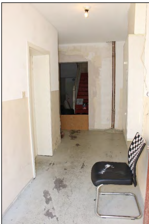
Foto Nr. 86: Gemeinschaftstreppehaus, Erdgeschoss
