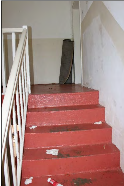
Foto Nr. 105: Gemeinschaftstreppe, Dachgeschoss
