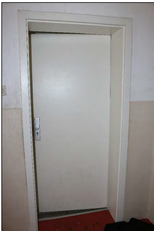
Foto Nr. 108: WE Nr. 4, Dachgeschoss rechts, Eingang
