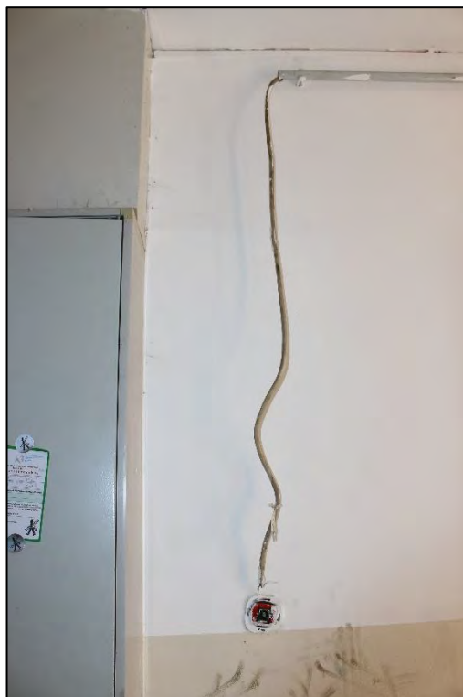
Foto Nr. 88: Gemeinschaftstreppe, Erdgeschoss, Elektroverlegung
