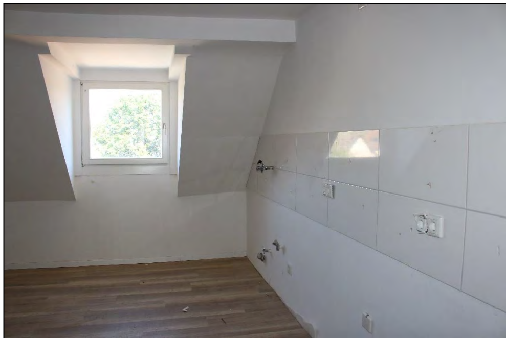
Foto Nr. 63: Dachgeschoss, WE Nr. 5, Küche
