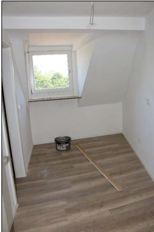
Foto Nr. 61: Dachgeschoss, WE Nr. 5, Raum 3
