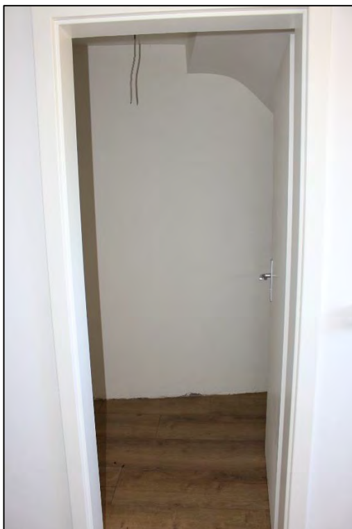
Foto Nr. 62: Dachgeschoss, WE Nr. 5, Abstellraum
