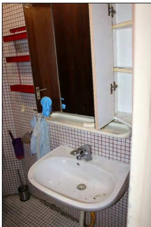
Foto Nr. 102: WE Nr. 2, Erdgeschoss rechts, Duschbad
