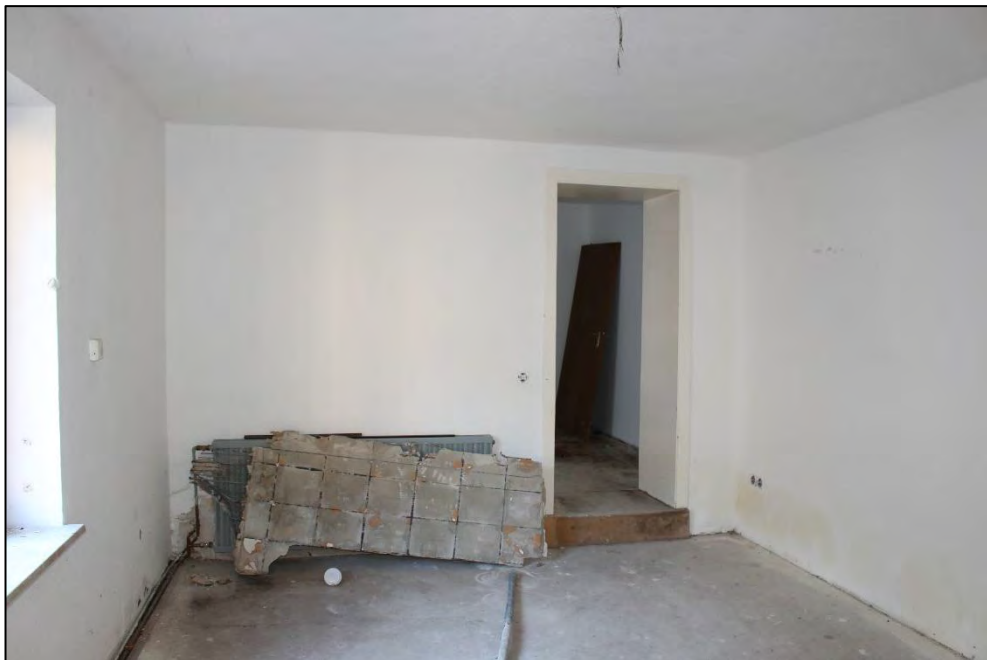
Foto Nr. 82: Anbau, Erdgeschoss, Raum 2
