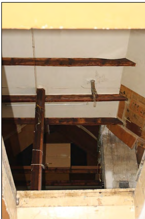
Foto Nr. 70: Dachboden
