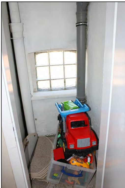
Foto Nr. 51: Gemeinschaftstreppenhaus, Dachgeschoss, Abstellraum Treppenpodest
