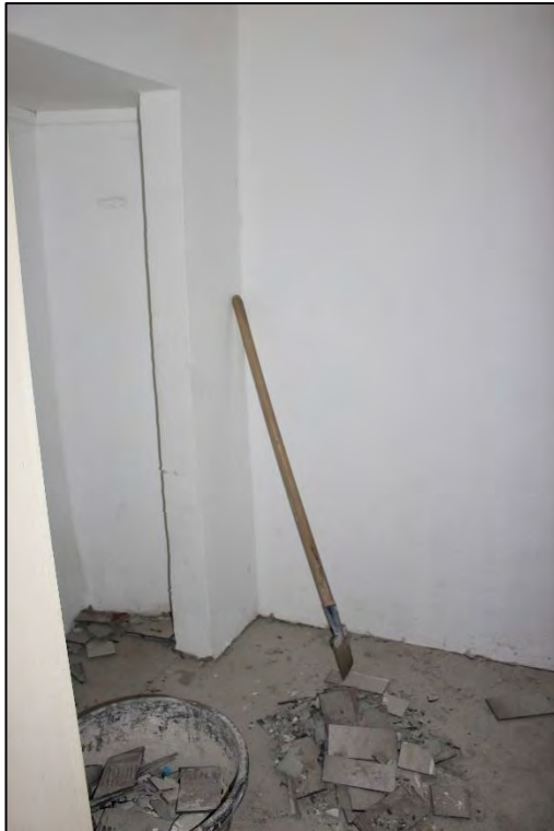
Foto Nr. 75: Anbau, Erdgeschoss, Flur
