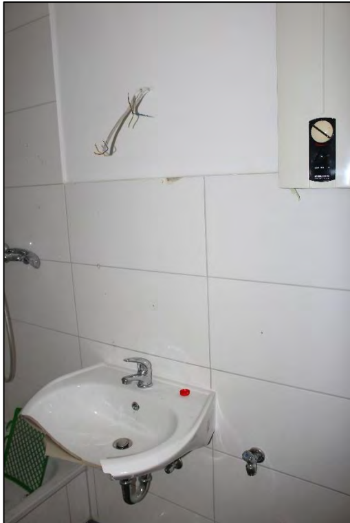
Foto Nr. 67: Dachgeschoss, WE Nr. 5, Bad
