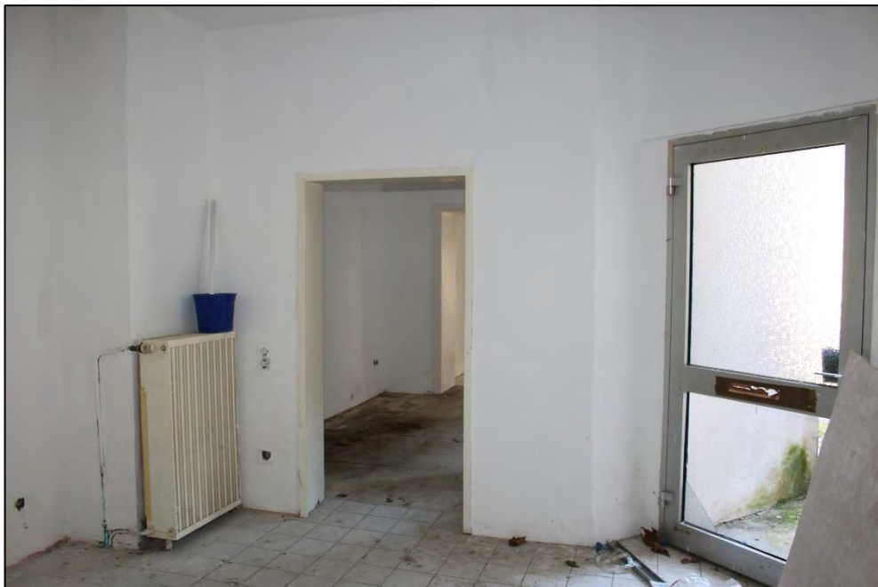
Foto Nr. 74: Anbau, Erdgeschoss, Küche / Eingang
