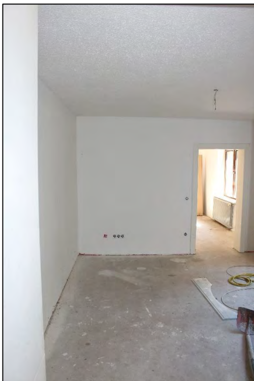
Foto Nr. 80: Anbau, Erdgeschoss, Raum 2
