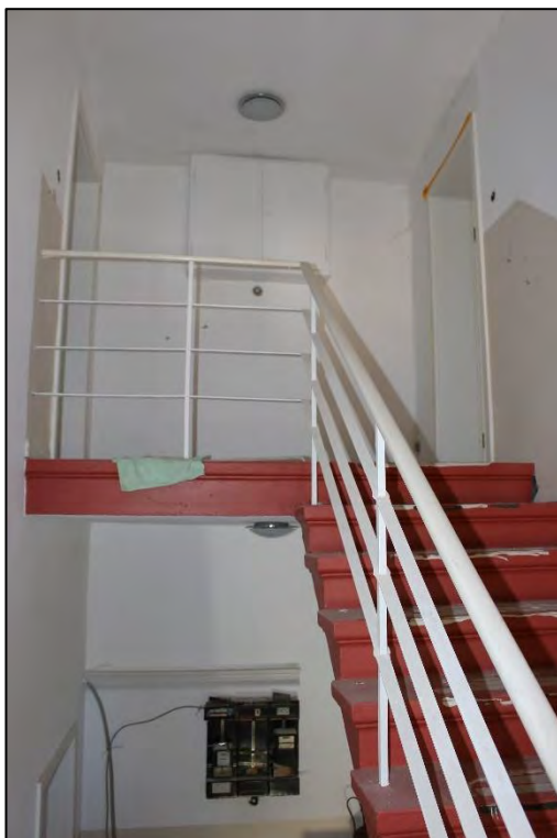
Foto Nr. 50: Gemeinschaftstreppenhaus, Dachgeschoss
