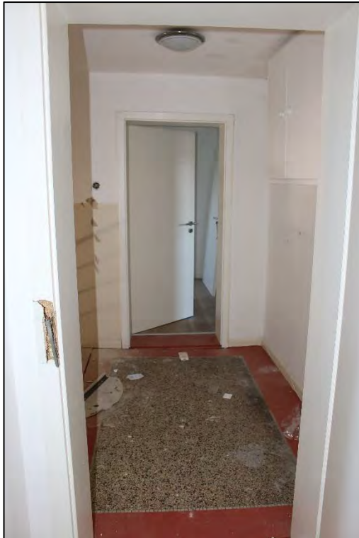
Foto Nr. 69: Gemeinschaftstreppe, Dachgeschoss
