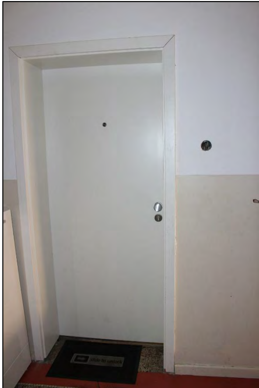
Foto Nr. 47: Gemeinschaftstreppenhaus, 2. OG, Eingang WE Nr. 3 links
