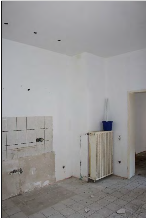
Foto Nr. 73: Anbau, Erdgeschoss, Küche
