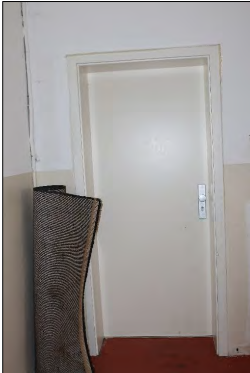
Foto Nr. 107: WE Nr. 3, Dachgeschoss links, Eingang
