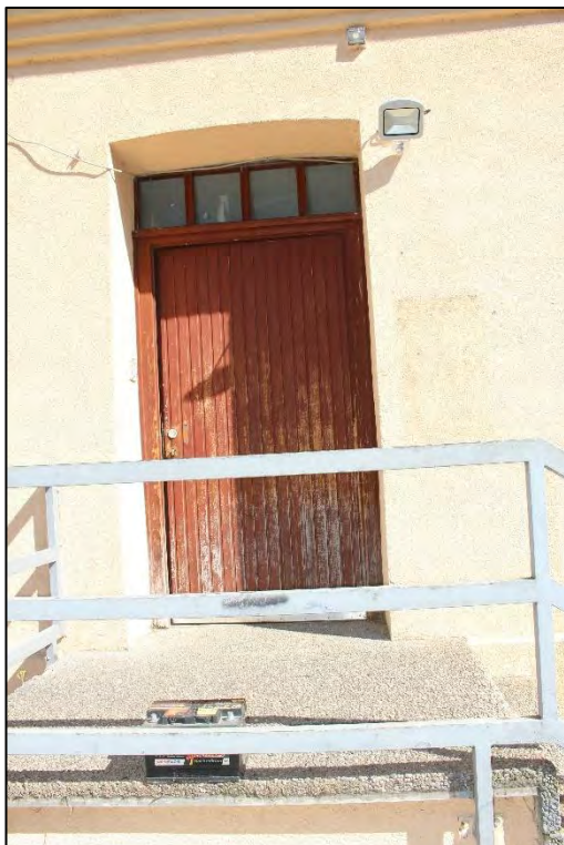
Foto Nr. 85: Hauseingang
