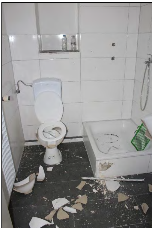
Foto Nr. 66: Dachgeschoss, WE Nr. 5, Bad
