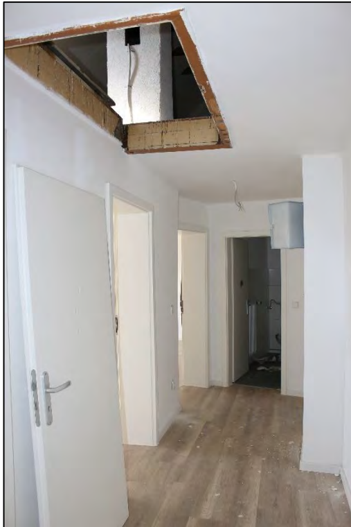
Foto Nr. 55: Dachgeschoss, WE Nr. 5, Diele links
