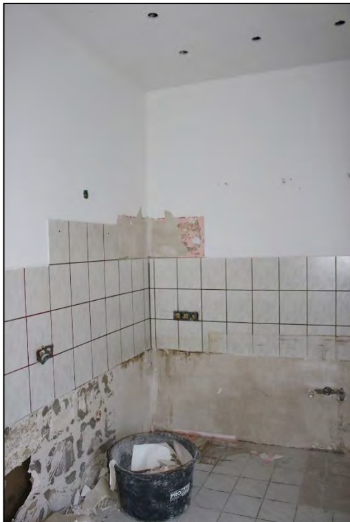
Foto Nr. 71: Anbau, Erdgeschoss, Küche
