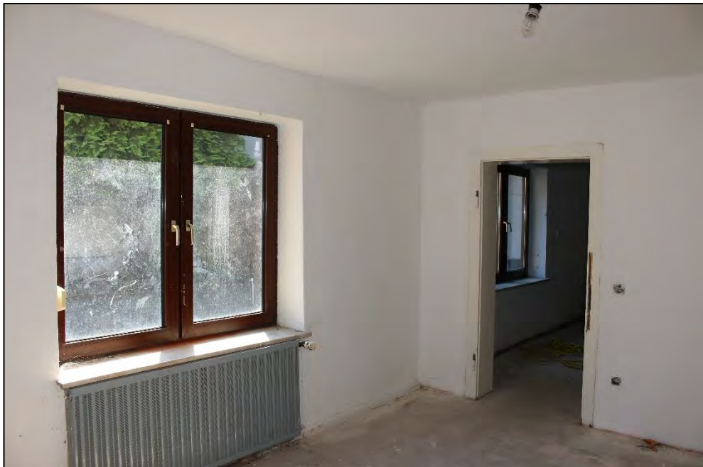
Foto Nr. 84: Anbau, Erdgeschoss, Raum 3
