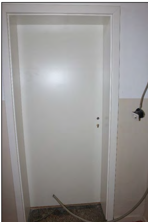
Foto Nr. 48: Gemeinschaftstreppenhaus, 2. OG, Eingang WE Nr. 4 rechts
