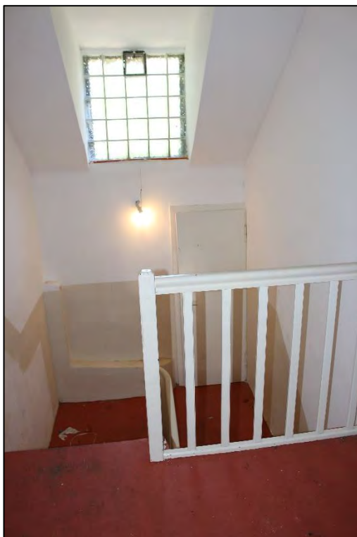
Foto Nr. 106: Gemeinschaftstreppe, Dachgeschoss
