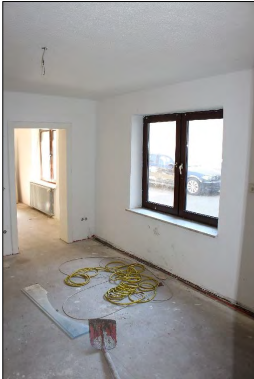
Foto Nr. 81: Anbau, Erdgeschoss, Raum 2
