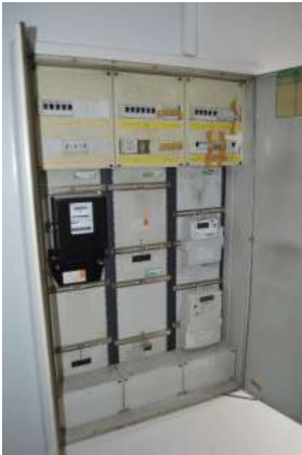
Bild 5: Bsp. Sicherungskasten
