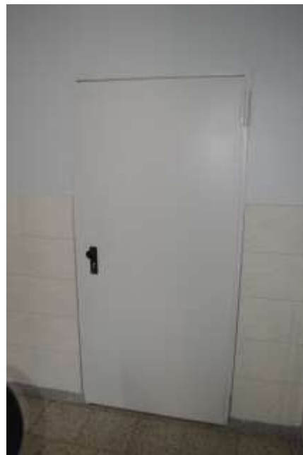
Bild 4: Zugang zur ETW Nr. 1 (vom Treppenhaus)
