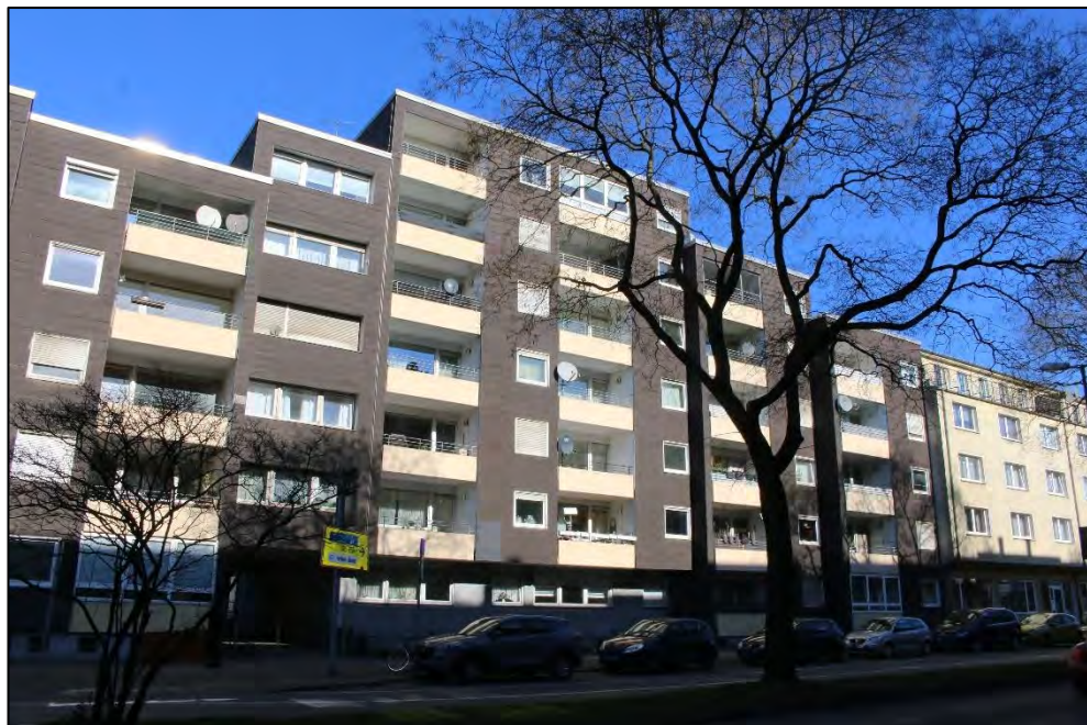
Foto Nr. 2: Straßenfassade, Wildenbruchstraße 19 / 21
