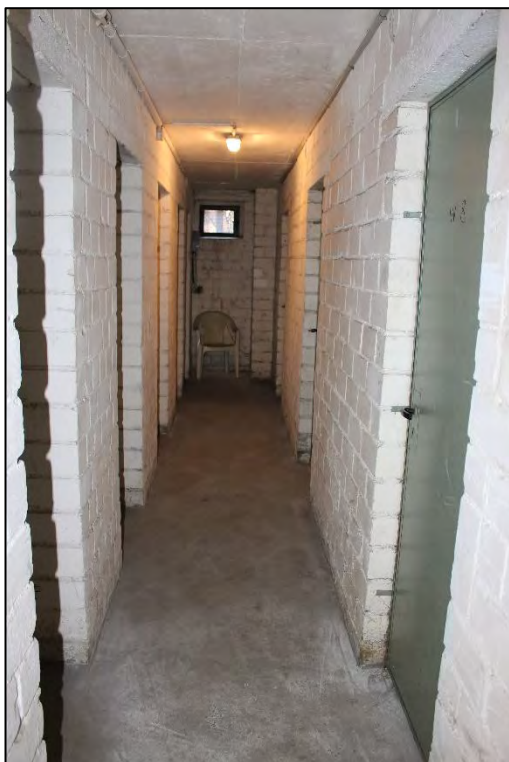
Foto Nr. 36: Kellergeschoss, Flur
