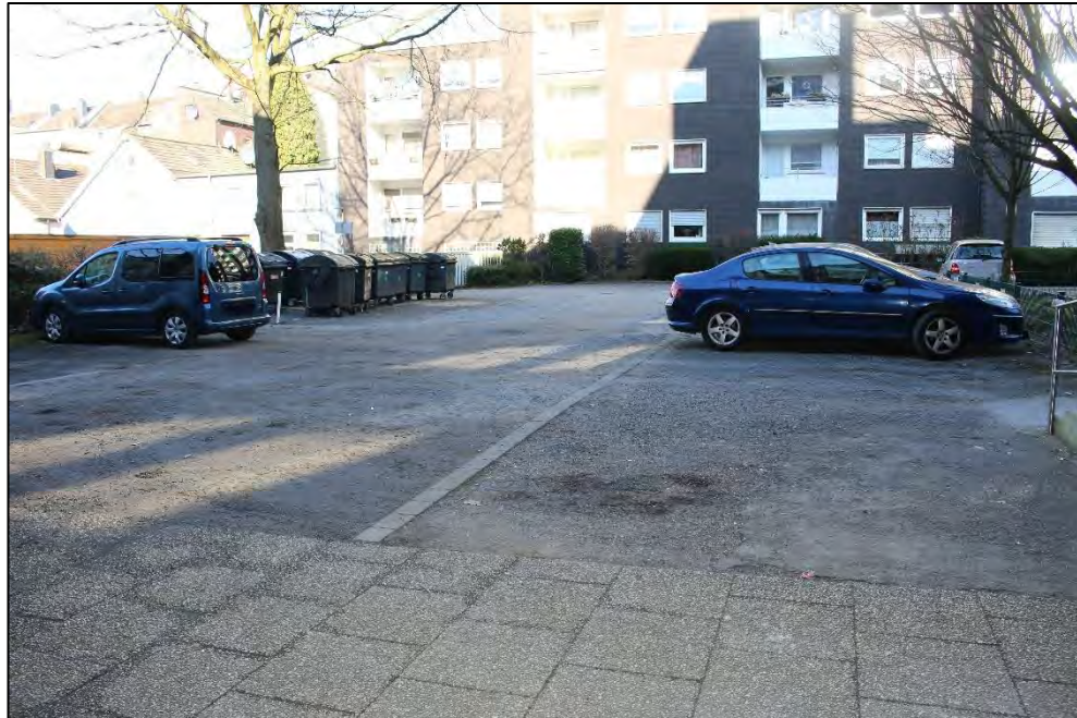
Foto Nr. 5: Hofffläche, Wildenbruchstraße 19 / 21
