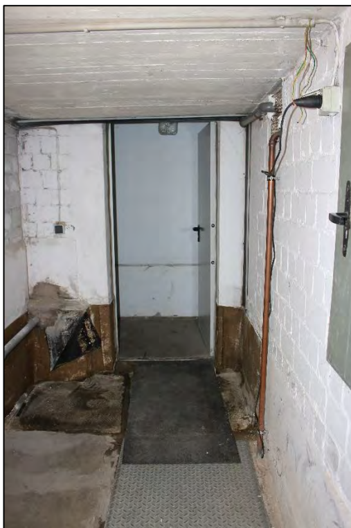
Foto Nr. 34: Kellergeschoss, Flur
