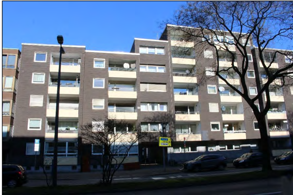
Foto Nr. 1: Straßenfassade, Wildenbruchstraße 19 / 21
