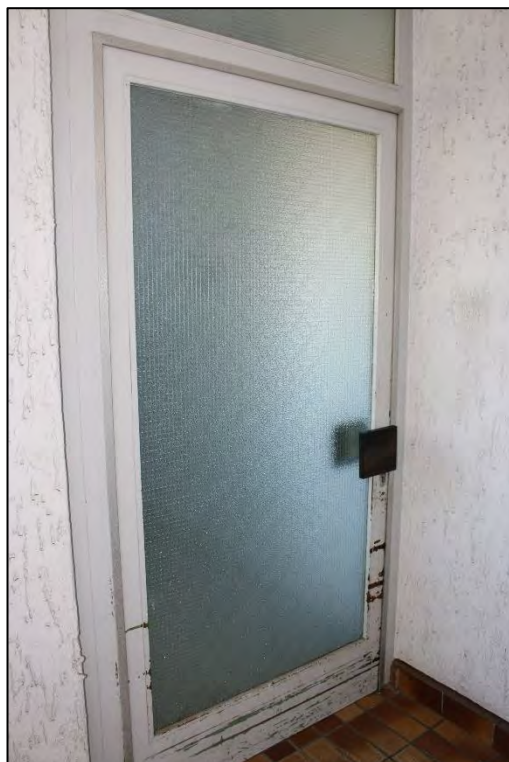
Foto Nr. 30: Tür vom Laubengang zum Gemeinschaftstreppenhaus
