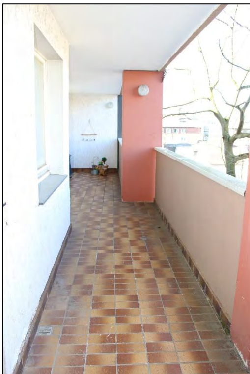
Foto Nr. 16: 3. OG, Laubengang
