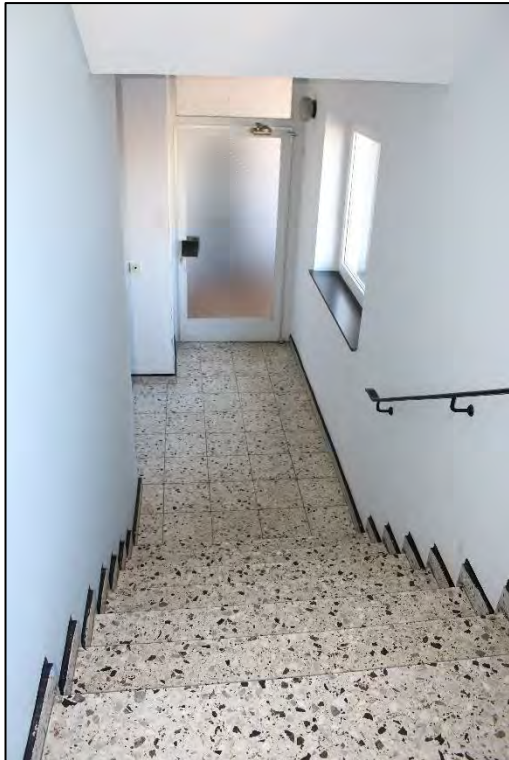
Foto Nr. 31: Gemeinschaftstreppehaus
