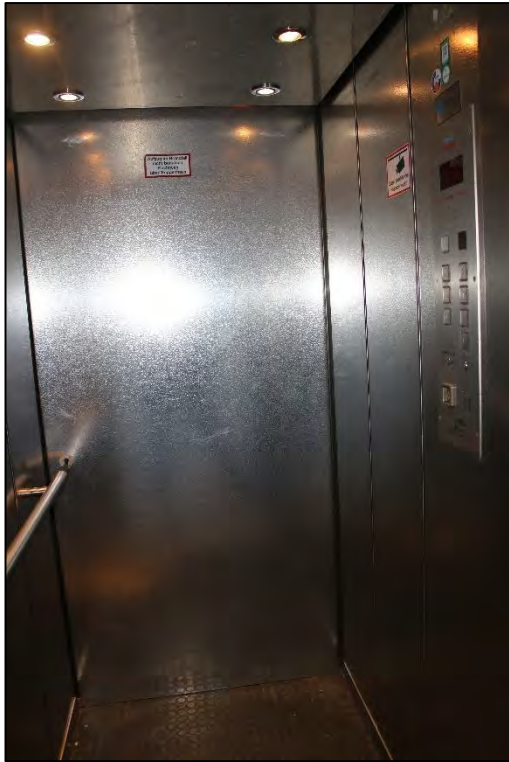
Foto Nr. 15: Gemeinschaftstreppe, Aufzugsanlage, innen
