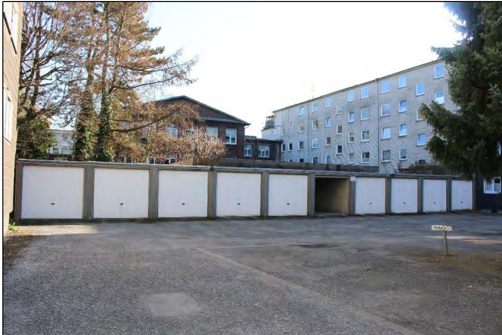
Foto Nr. 11: Garagenhof
