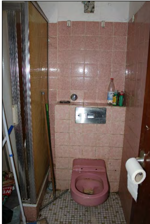
Foto Nr. 23: ETW Nr. 23, 3. OG, Bad
