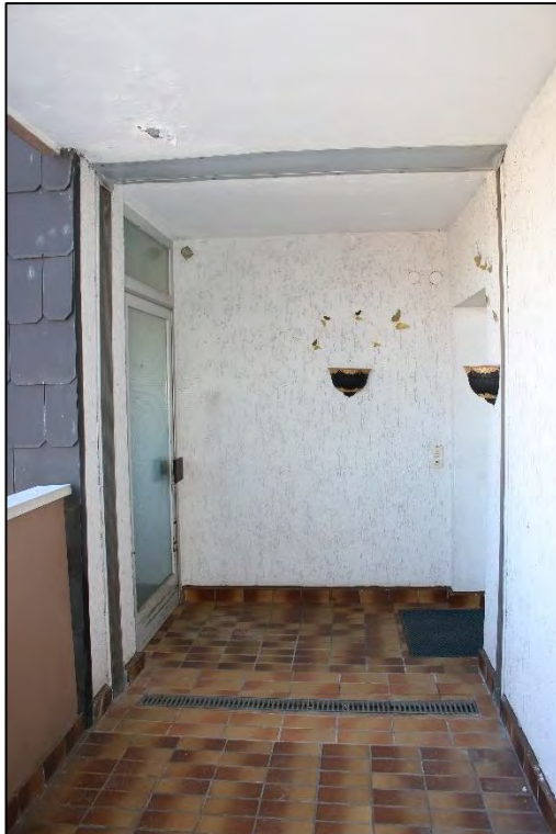
Foto Nr. 17: 3. OG, Laubengang
