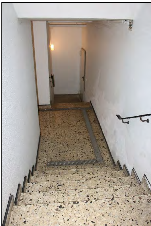
Foto Nr. 32: Gemeinschaftstreppehaus, Treppe zum Kellergeschoss
