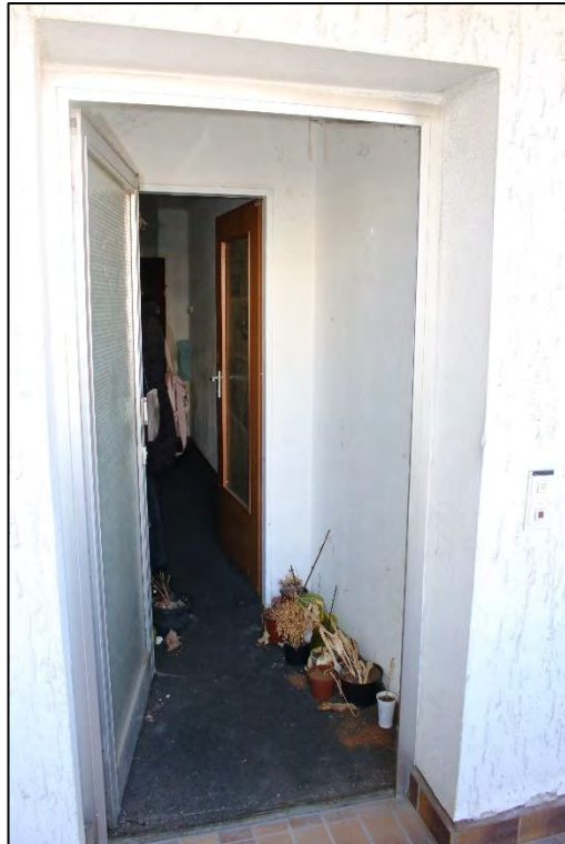
Foto Nr. 29: ETW Nr. 23, 3. OG, Eingang vom Laubengang
