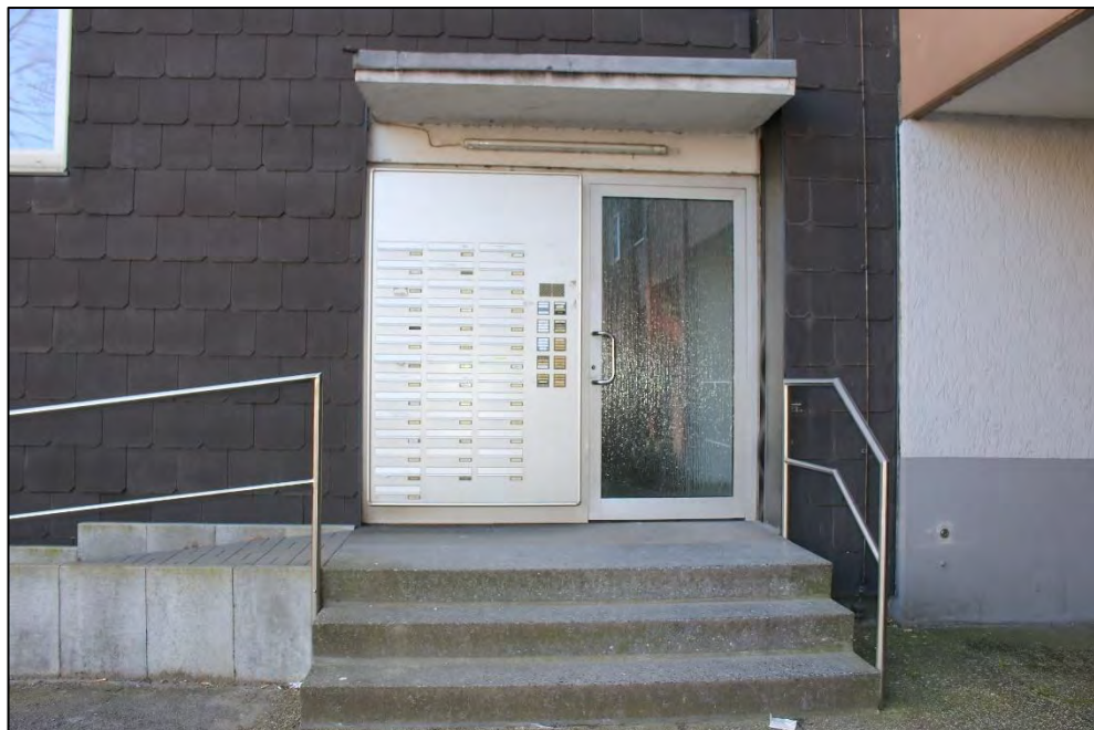
Foto Nr. 8: Hauseingang, Wildenbruchstraße 19 / 21
