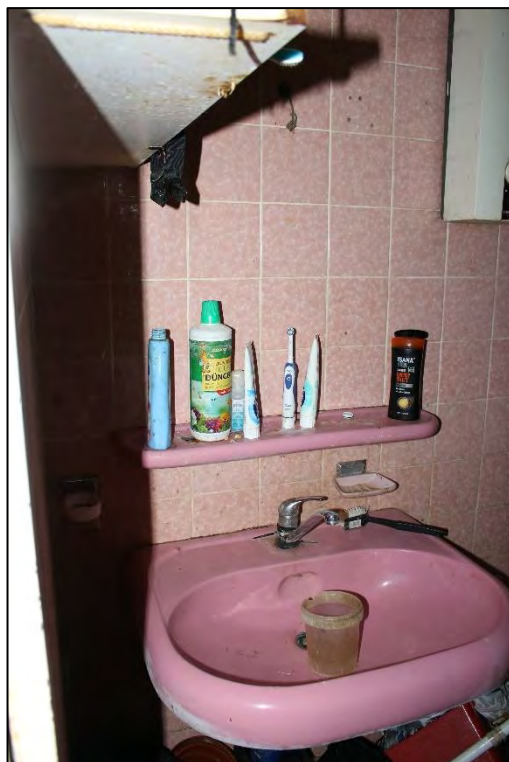
Foto Nr. 22: ETW Nr. 23, 3. OG, Bad
