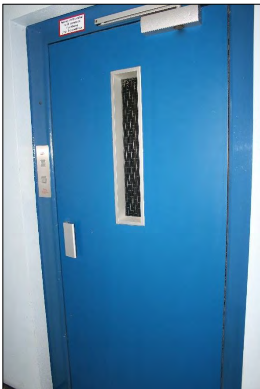
Foto Nr. 14: Gemeinschaftstreppenhaus, Aufzugsanlage
