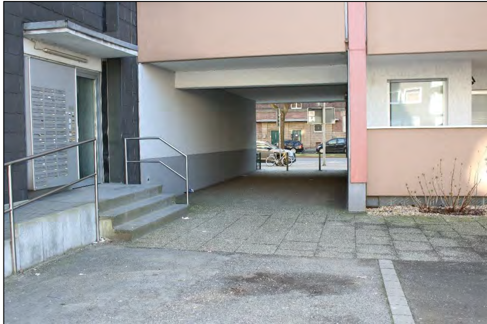
Foto Nr. 7: Durchgang / Eingang, Wildenbruchstraße 19 / 21
