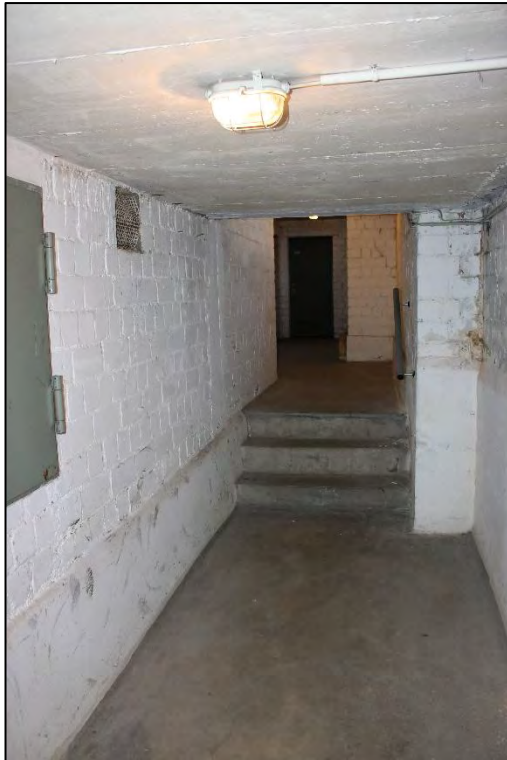
Foto Nr. 33: Kellergeschoss, Flur
