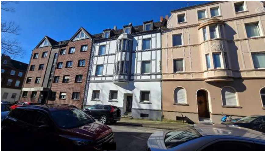
Straßenseitiger Blick auf das Mehrfamilienhaus.
