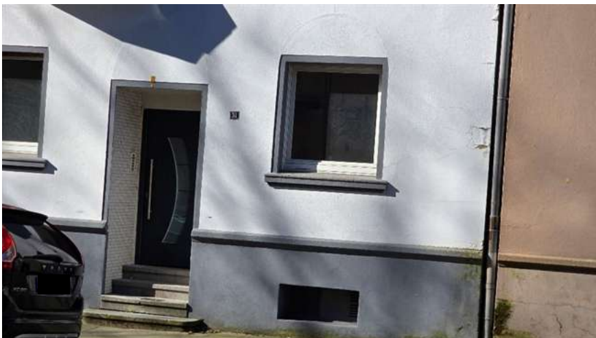
Hauseingangsbereich und Verschmutzung der Fassade im Sockelbereich.
