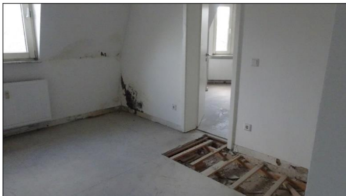
22) Sondereigentum Nr. 16/ defekter Fußboden
