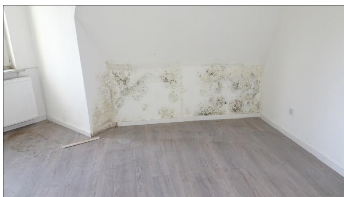
20) Sondereigentum Nr. 16/ Feuchtschäden
