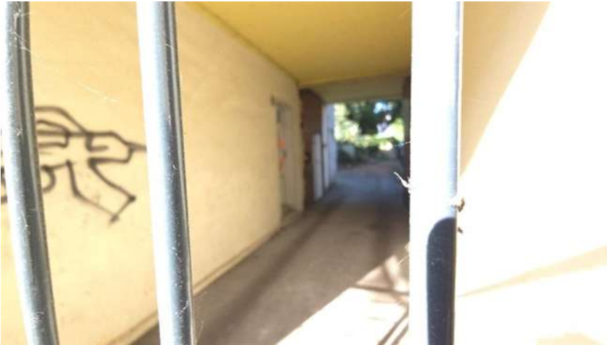
Hofdurchfahrt von der Belforter Straße.
