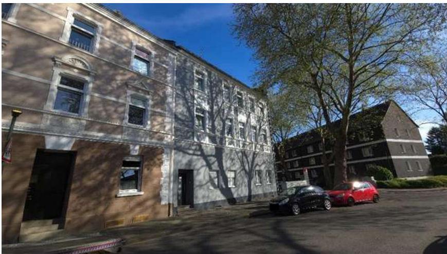
Hauseingang Lothringer Straße und Darstellung der sanierten Fassade.
