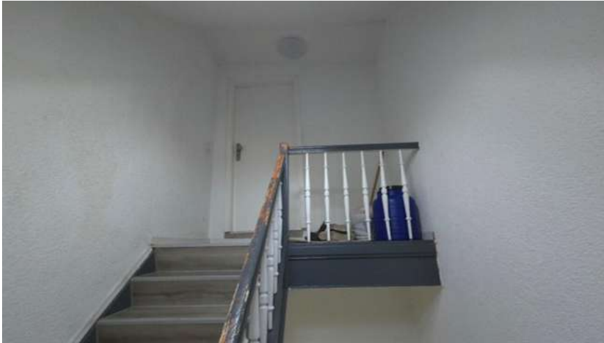
Treppenhaus Lothringer Str. 24 mit Blick auf die Wohnungsabschlusstür zu WE 4.
