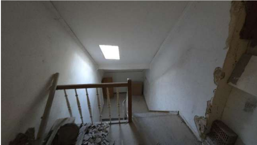
Treppenhaus Belforter Str. 30 im DG.
