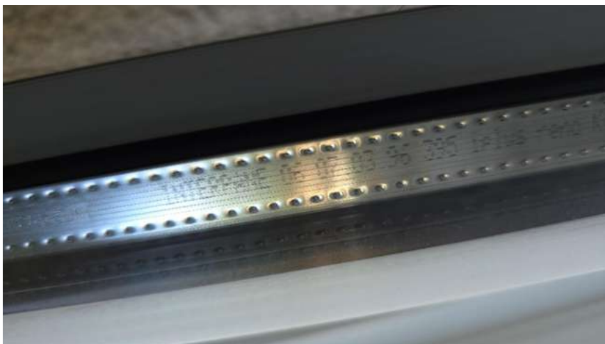
Prägung im Fensterglas; Datum der Herstellung: 07.03.1996.
