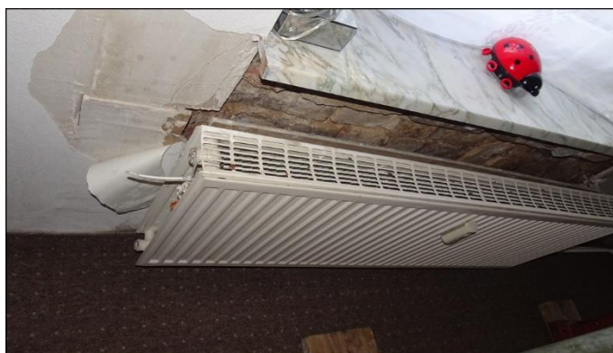
13) Sondereigentum Nr. 14/ Schäden Wandbelag
