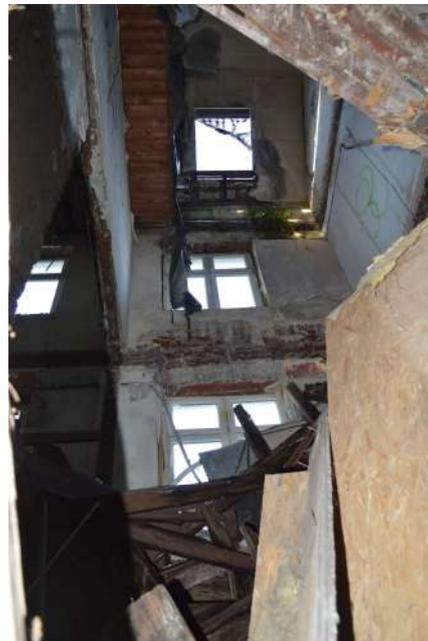
Bild 20: Dachundichtigkeit und abgestürzte
