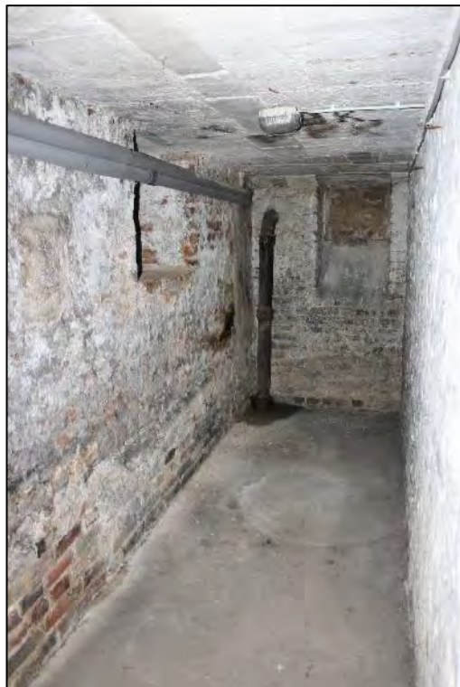
Foto Nr. 10: Kellergeschoss, Kellerraum
