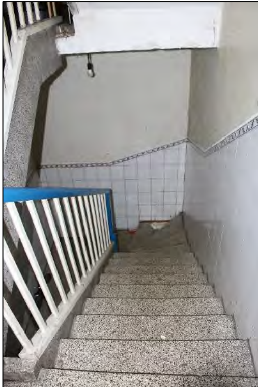
Foto Nr. 37: Gemeinschaftstreppehaus, Treppe zum 1. OG
