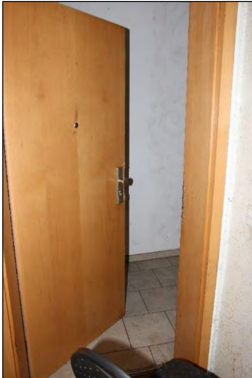
Foto Nr. 81: 3. OG rechts, ETW Nr. 7, Eingang
