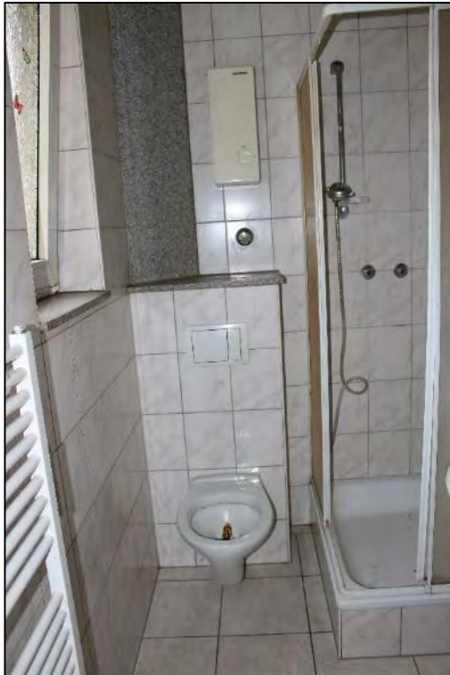
Foto Nr. 57: 1. OG links, ETW Nr. 3, Bad
