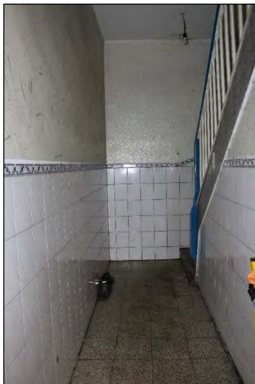
Foto Nr. 36: Gemeinschaftstreppehaus, Erdgeschoss
