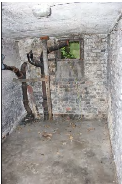
Foto Nr. 16: Kellergeschoss, Kellerraum
