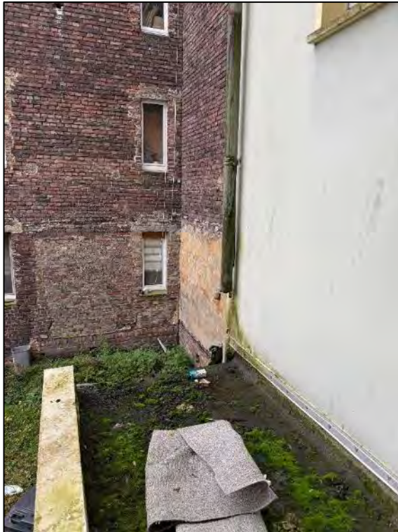
Foto Nr. 5: Hoffassade
