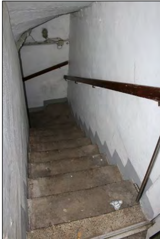
Foto Nr. 9: Treppe zum Kellergeschoss
