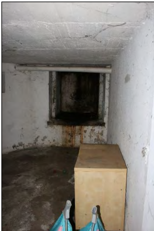
Foto Nr. 12: Kellergeschoss, Kellerraum, Bierkeller
