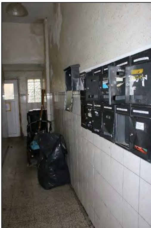
Foto Nr. 8: Gemeinschaftstreppe, Erdgeschoss
