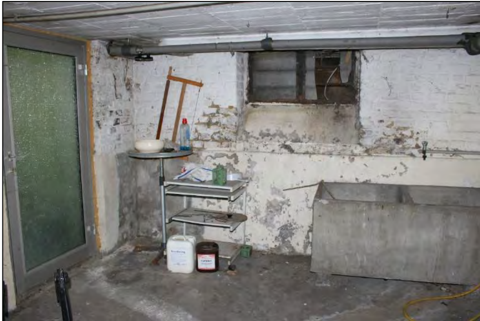
Foto Nr. 15: Kellergeschoss, Waschküche / Kelleraußeneingang
