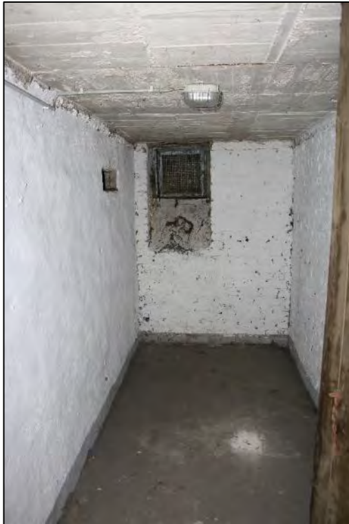
Foto Nr. 11: Kellergeschoss, Kellerraum
