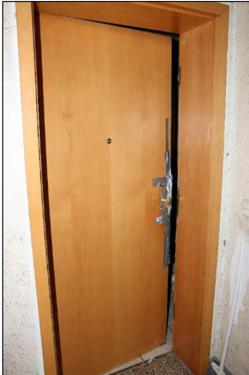
Foto Nr. 59: 2. OG rechts, ETW Nr. 4, Eingang
