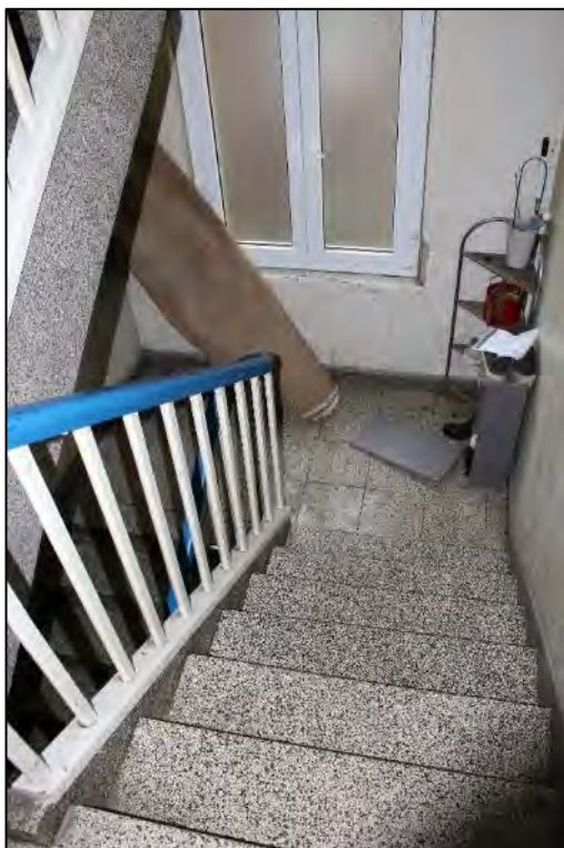
Foto Nr. 58: Gemeinschaftstreppe, Treppe zum 2. OG
