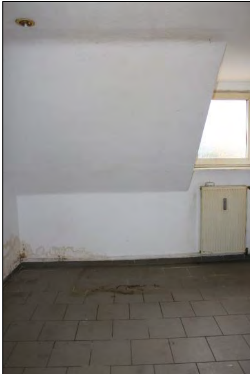
Foto Nr. 123: DG mittig, ETW Nr. 11, Küche
