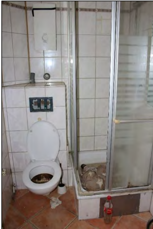
Foto Nr. 105: 3. OG links, ETW Nr. 9, Bad
