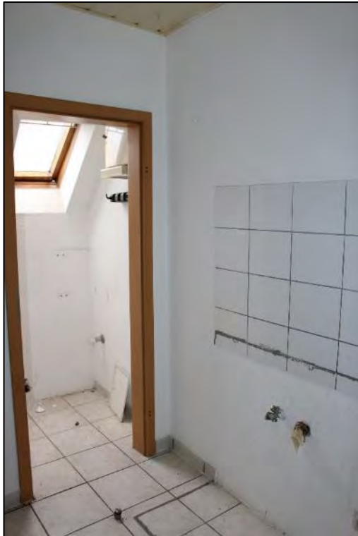
Foto Nr. 113: DG rechts, ETW Nr. 10, Küche / Abstellraum
