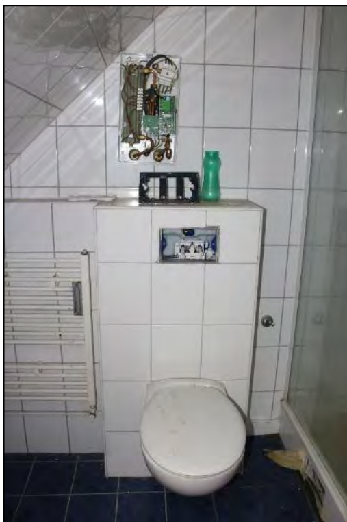
Foto Nr. 118: DG rechts, ETW Nr. 10, Bad
