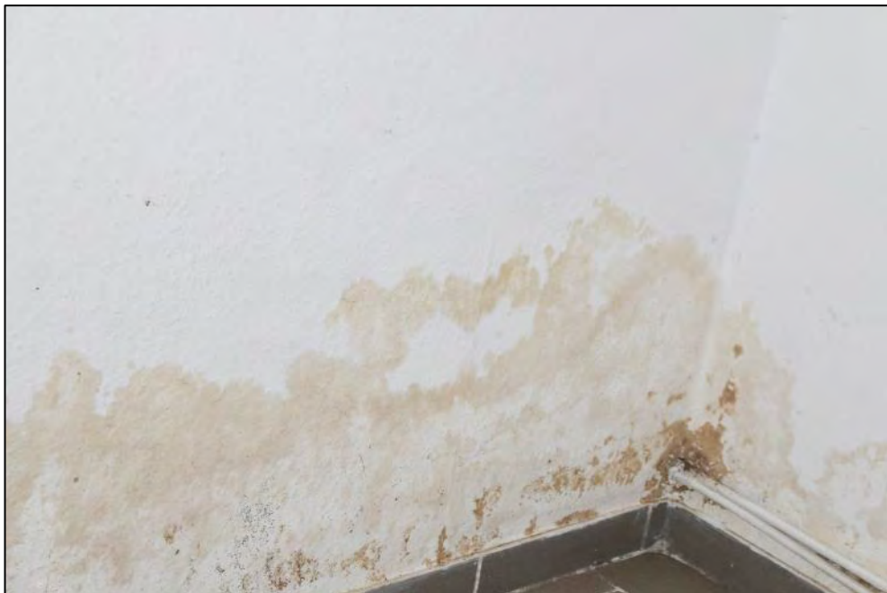
Foto Nr. 124: DG mittig, ETW Nr. 11, Küche
