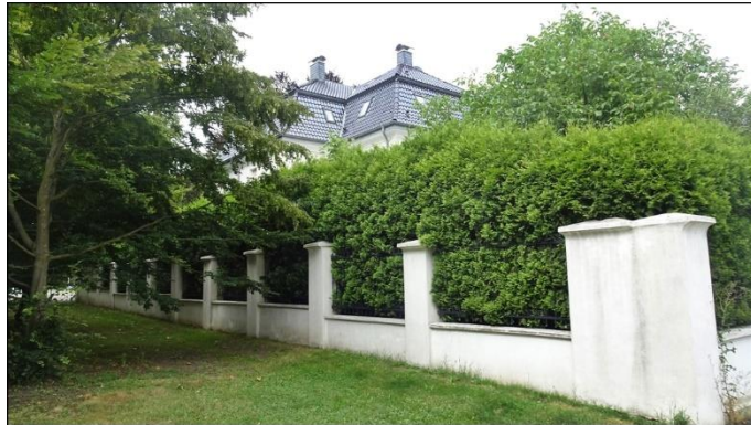
7) Ansicht entlang der Grundstückseinfriedung
