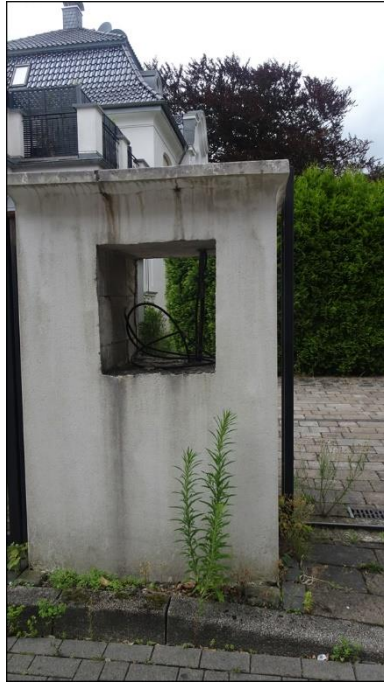
4) Detailfoto Mauerpfeiler Einfriedung
