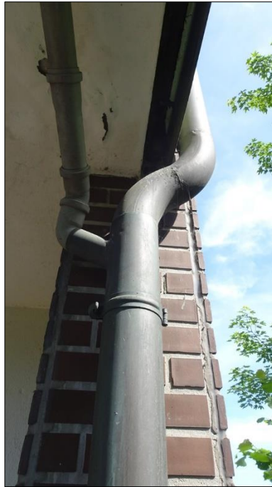
7) Detailfoto Balkonuntersicht/ Entwässerung
