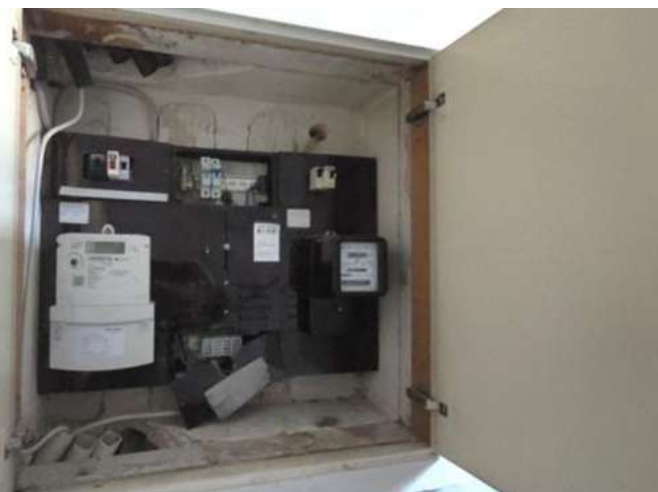
Zählerschrank mit 2 Sicherungsautomaten, ohne FI-Schutzschalter.
