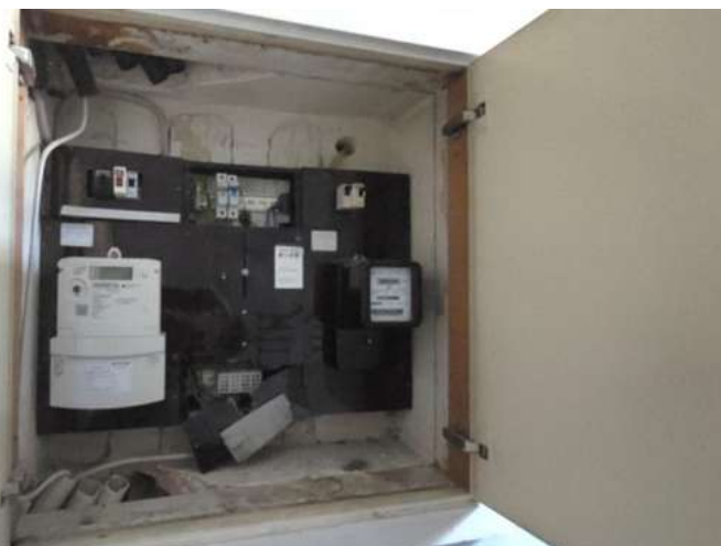
Zählerschrank mit Sicherungsautomaten. Der mittlere Zählerplatz zu WE 18 ist nicht besetzt. Die Sicherungsautomaten sind in einem desolaten Zustand.
